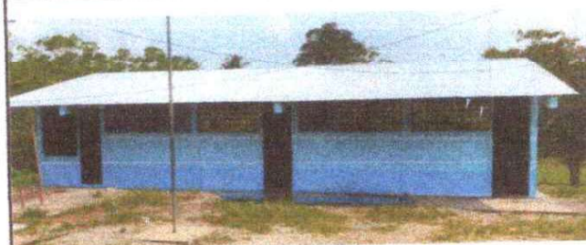
Foto 4: POSTERIOR A SUSTITUCION DEL TECHADO DE TERCERO Y CUARTO PRIMARIA. QUINTO Y SEXTO PRIMARIA.
