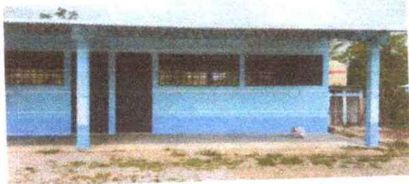
Foto1: POSTERIOR A SUSTITUCION DEL TECHADO DE LAS AULAS DE PARVULOS I,II Y III.
