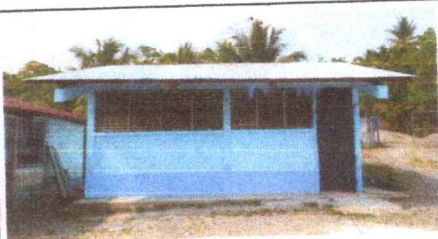
Foto 3: POSTERIOR A SUSTITUCION DEL TECHADO DE PRIMERO Y SEGUNDO PRIMARIA.
