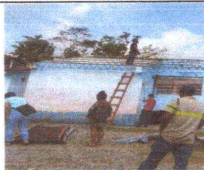
Foto 2: SUSTITUCION DE TECHADO DE LA DIRECCION.
