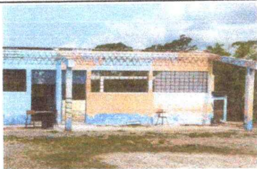
Foto 1: SUSTITUCION DEL TECHADO DE LAS AULAS DE PARVULOS I, II Y III.
