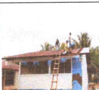
Foto 3: SUSTITUCION DE PISO Y TECHADO DEL AULA DE PRIMERO Y SEGUNDO PRIMARIA.
