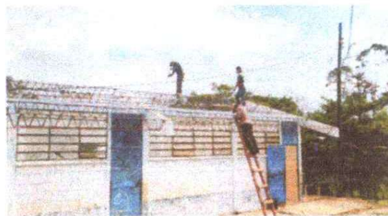
Foto 4: SUSTITUCION DE PISO Y TECHADO DEL AULA DE TERCERO Y CUARTO PRIMARIA. QUINTO Y SEXTO PRIMARIA.
