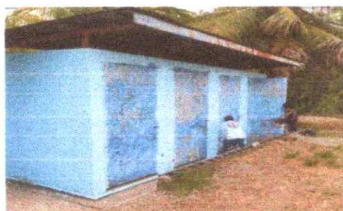
Foto 6: SUSTITUCION DE PUERTAS DE LOS BAÑOS PARA PRIMARIA.
