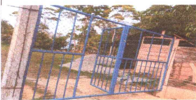
PORTON DEL MURO PERIMETRAL
