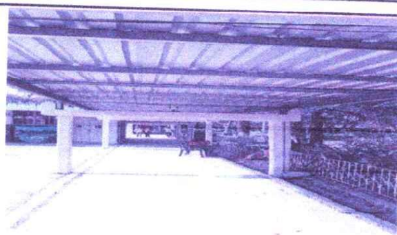
Foto 4: LAMINADO FINAL DEL AREA DE AULA 16
