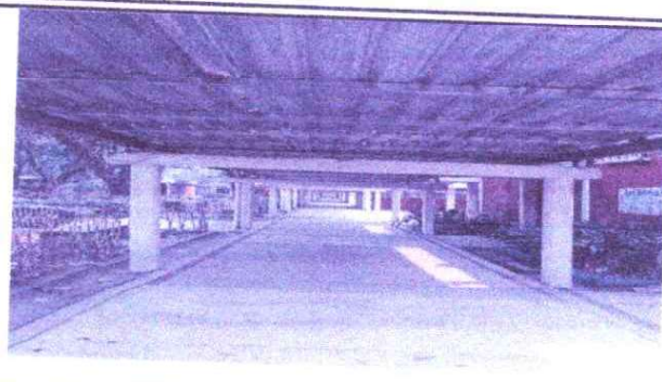
Foto 2: LAMINADO DEL AREA DE PASILLOS AREA DE CASETAS
