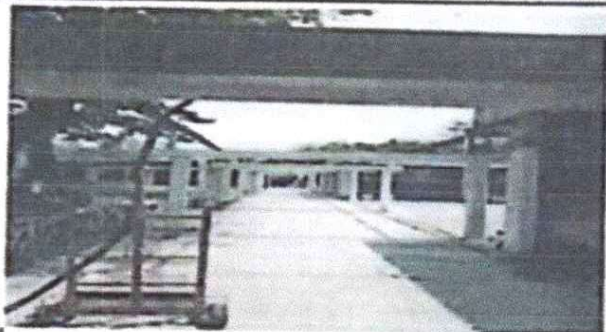
Foto 1: DESMONTAJE DE LAMINA EN PASILLO DEL AULA 8 A LA 18
