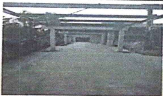
Foto 3: DESMONTAJE DE LAMINA EN PASILLO DE LA ENTRADA PRINCIPAL
