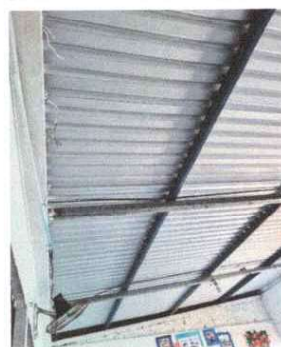
Foto 2: Colocación de lámina
