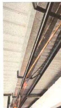
Foto 4: Colocación de canal
