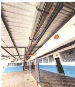
Foto 5: Colocación de canal
