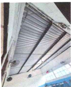
Foto 3: Colocación de lámina
