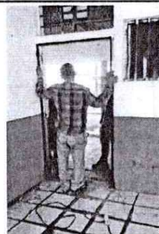
Foto 6: Sustitución de puerta
