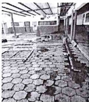
Foto 1: Corte de piso y fundición
