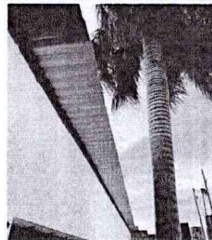
Foto 2: Sustitución de lámina
