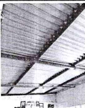
Foto 3: Sustitución de lámina
