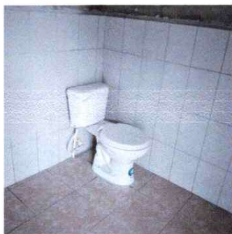
Foto 3: Tasa sanitaria instalada
