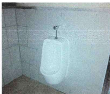
Foto 5: Mingitorio instalado
