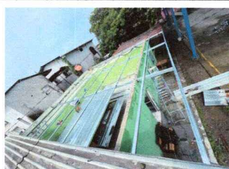
Foto 4: Instalando techo de lamina
