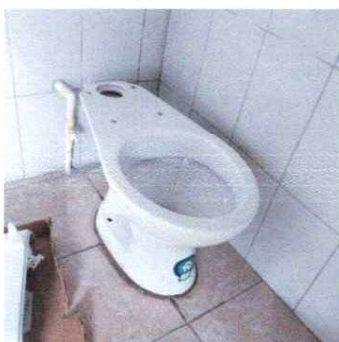
Foto 3: Instalando tasa sanitaria
