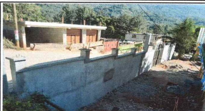
Foto 2: Reparación de muro o tapial
