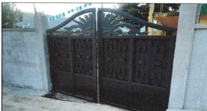
Foto 4: Sustitución de portón.
