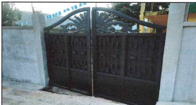
Foto 3: Sustitución de portón.
