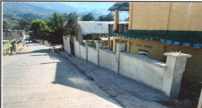
Foto 1: Reparación del muro o tapial
