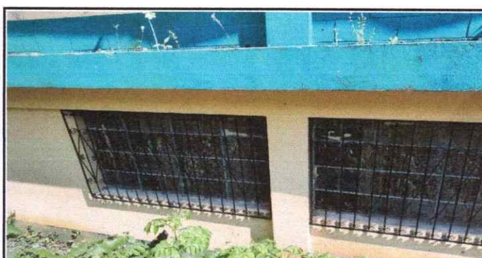
Foto 6: Sustitución de vidrios y colocación de balcones.
