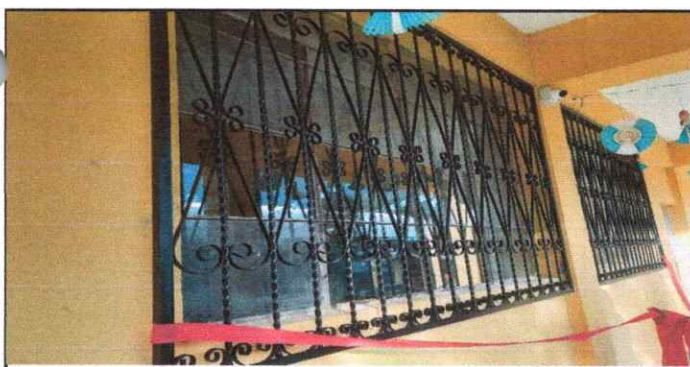
Foto 5: Sustitución de vidrios y colocación de balcones.
