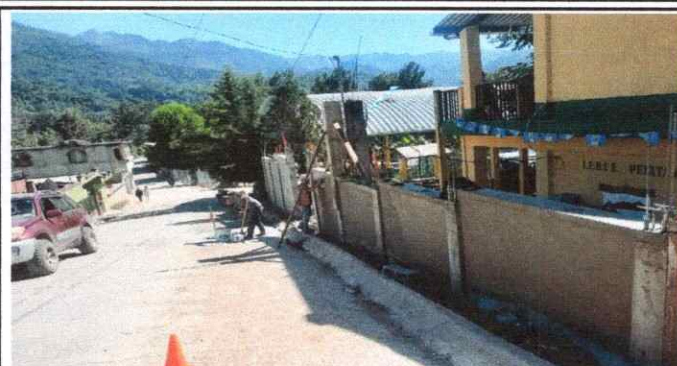
Foto 2: Reparación de muro o tapial
