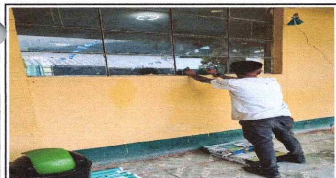
Foto 5: Sustitución de vidrios y colocación de balcones.
