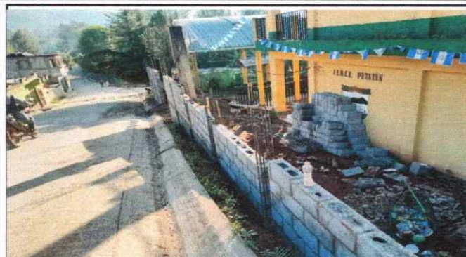
Foto 1: Reparación del muro o tapial
