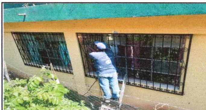
Foto 6: Sustitución de vidrios y colocación de balcones.
