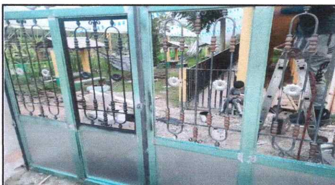
Foto 4: Sustitución de portón.
