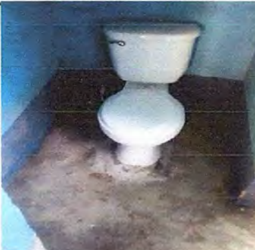
Foto 4: Sustitución de inodoro
