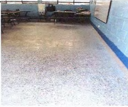
Foto 1: sustitucion de piso de granito
