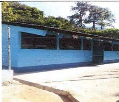
Foto 5: Pintura de muros exteriores e inferiores
