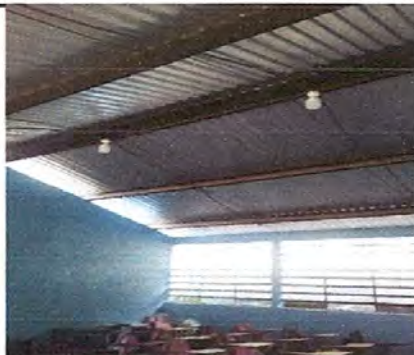
Foto 6: Sustitución de cableado, focos ahorradores, plafoneras, interruptores y tomacorrientes
