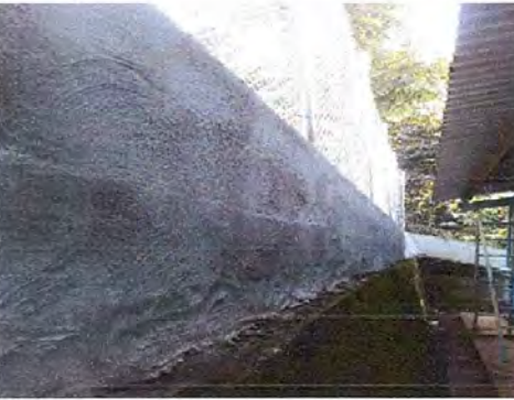
Foto 3: Reparación de muro de contención
