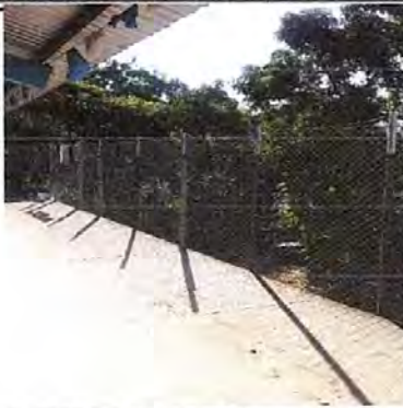
Foto7: sustitución de postes de madera por postes de metal
