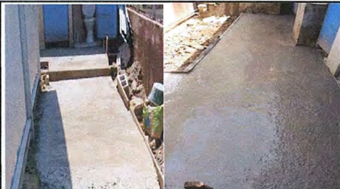
Foto 7: sustitución de piso de torta de concreto
