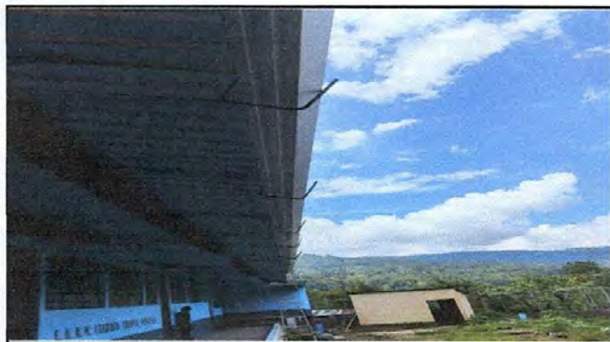
Foto 3: sustitución de canal de metal
