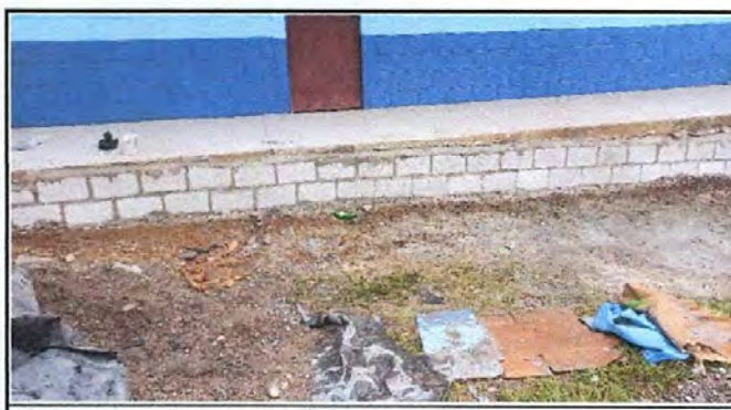
Foto 5: reparación de muro contención con block
