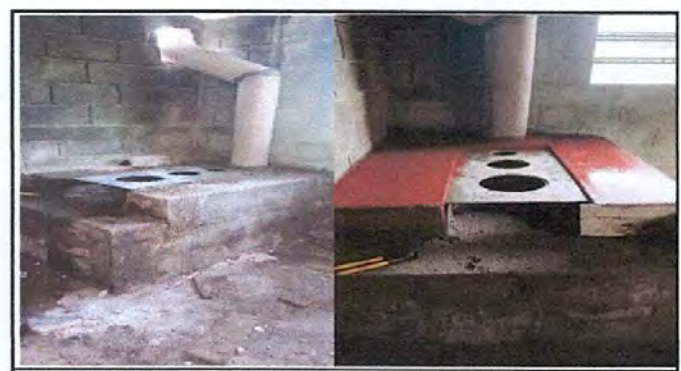
Foto 6: sustitución de chimenea de concreto y sustitución de plancha de metal de 3 hornillas
