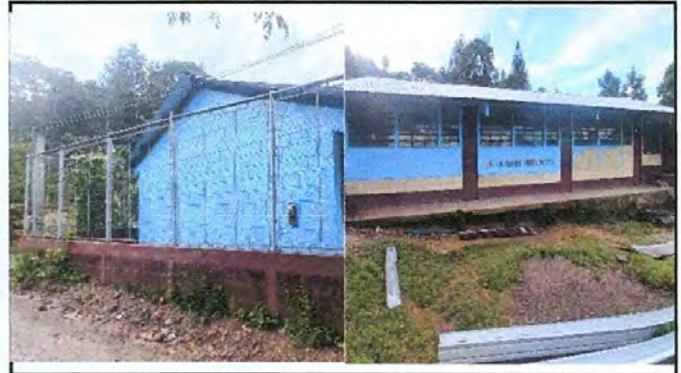
Foto 2: pintura en muros exteriores e interiores
