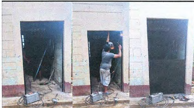
Foto 2: sustitución de puerta
