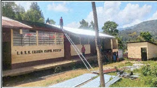
Foto1: sustitución de lámina, por lámina maxalum C26
