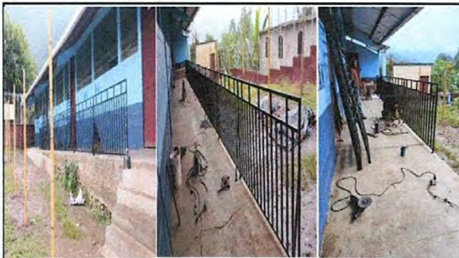
Foto 3: sustitución de baranda de madera, por baranda de metal
