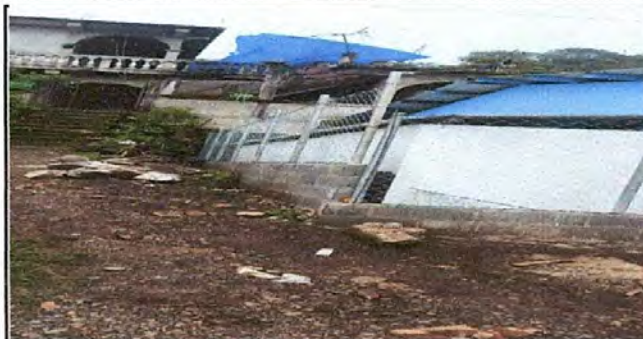
Foto 2: Sustitución de malla perimetral
