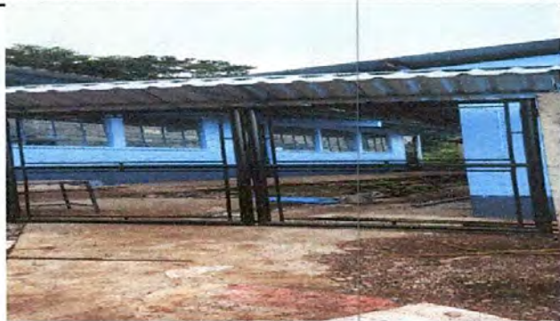
Foto1: Sustitución de pintura inferior e exterior
