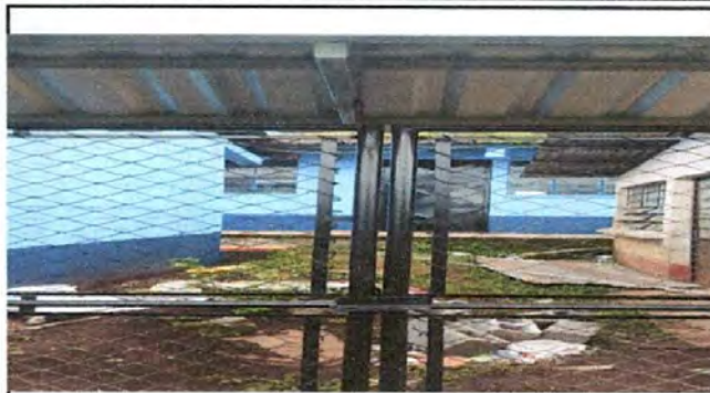
Foto 7 : Sustrución de porton
