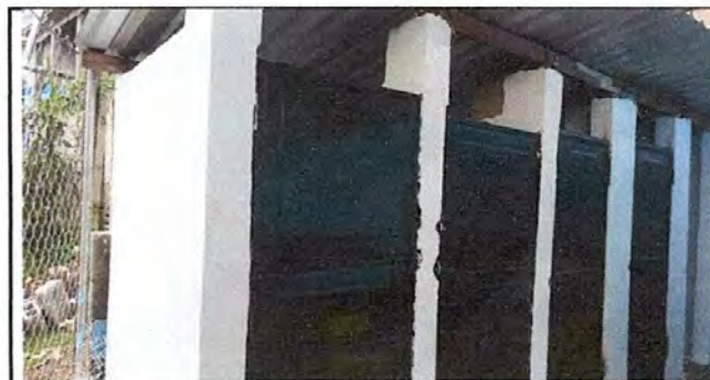
Foto 6: Reparación de baños
