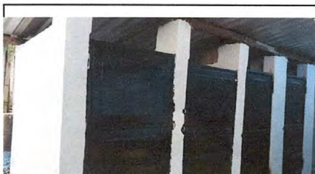
Foto 9: Sustrución de puerta de baños
