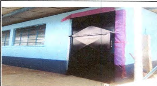
Foto 6: Sustrución de pintura de puertas
