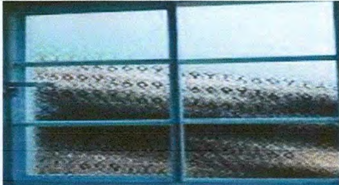
Foto 2: Sustitución de vidrios en ventanas
