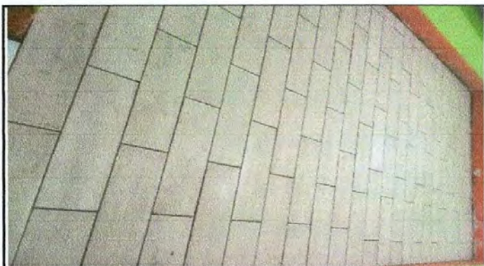
Foto 3: Sustitución de piso de torta por cerámico
