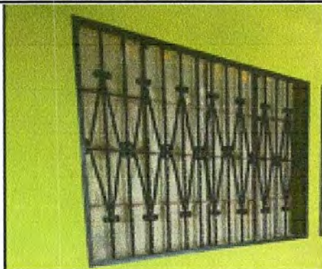
Foto7: Fabricación e instalación de balcones en ventanas
