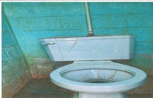
Foto 3. Sustitución de inodoros.
