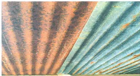
Foto 1. Sustitución de lámina por lámina troquelada.
