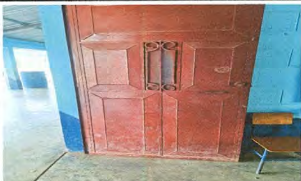
Foto 3: mantenimiento de estructura.
