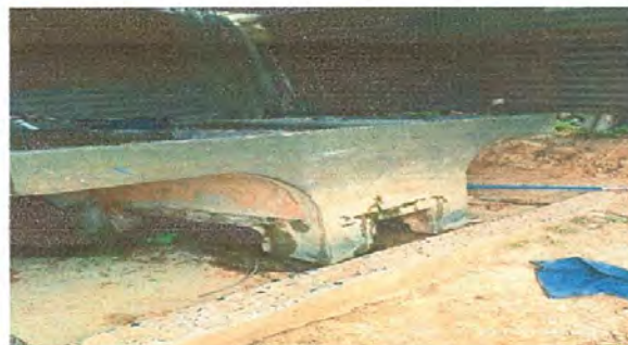
Foto 4. Sustitución de pila de cemento.
