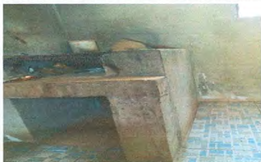
Foto 5. Instalación de azulejo en estufa rural.
