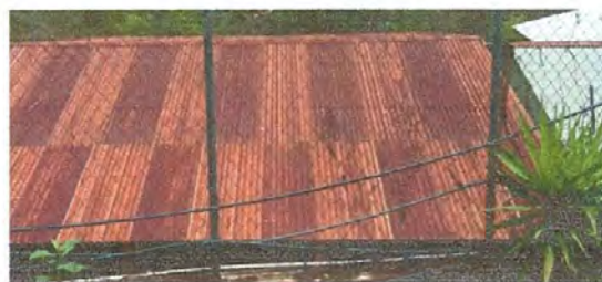
Foto 6: Sustitución de lámina por lámina troquelada
