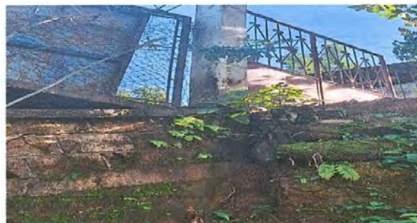
Foto 4: reparación de muro perimetral
