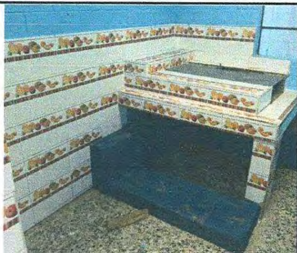
Foto 7: Sustitución de la plancha de metal de tres hornillas y colocación de azulejo finalizada en el área de estufa rural.
