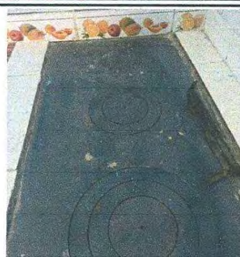
Foto 8: Sustitución finalizada de la plancha de metal de tres hornillas.
