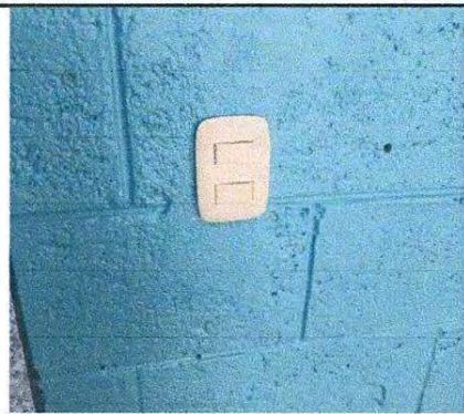
Foto 14: Interruptor doble sustituido por uno nuevo.
