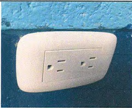
Foto 15: Tomacorriente doble sustituido por uno nuevo.
