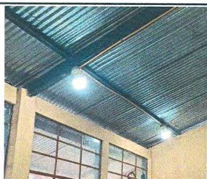
Foto 11: Colocación de bombillos led.
