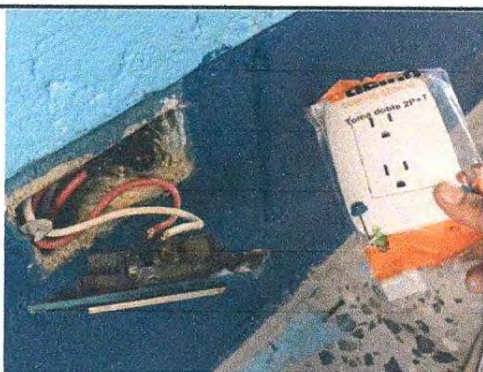
Foto 15: Sustitución de tomacorriente doble.
