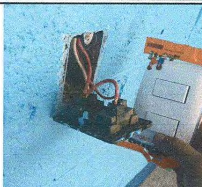
Foto 14: Sustitución de interruptor doble.
