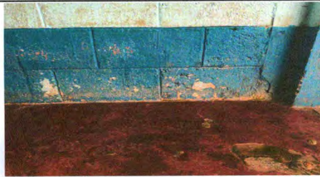
Foto 6: La parte del zócalo es mas afectada debido a que está mayormente expuesta a humedad y otros factores que la deterioran.
