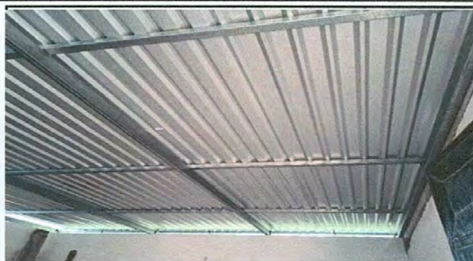
Foto 2: Trabajo finalizado en la sustitución de techo y soporte de madera por metal.
