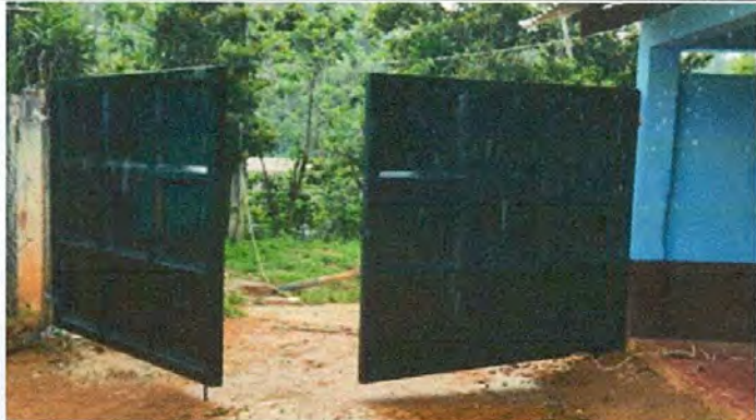
Foto1: Trabajo finalizado en la sustitución del portón.
