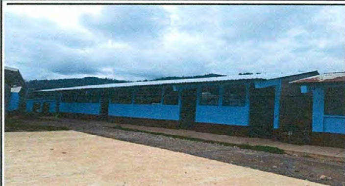
Foto1: El trabajo finalizado en la sustitución de lámina.
