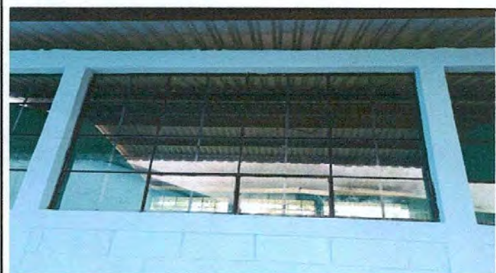
Foto 3: Trabajando finalizado en la sustitución de vidrios
