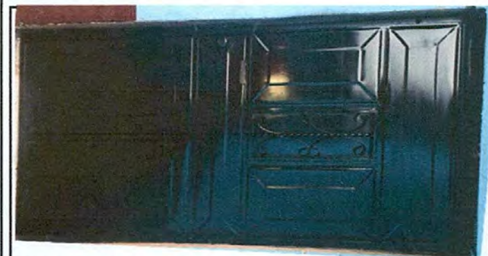
Foto 5: Pintura y mantenimiento de puertas finalizado.
