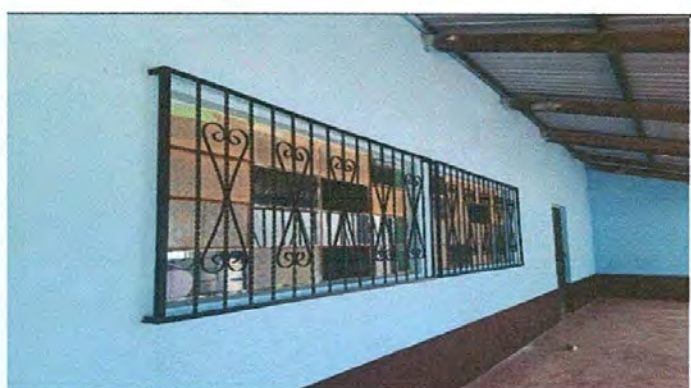
Foto 4: Trabajo finalizado en la sustitución de balcones
