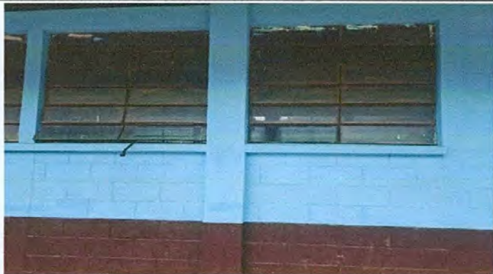
Foto 2: Trabajo de la pintura finalizado
