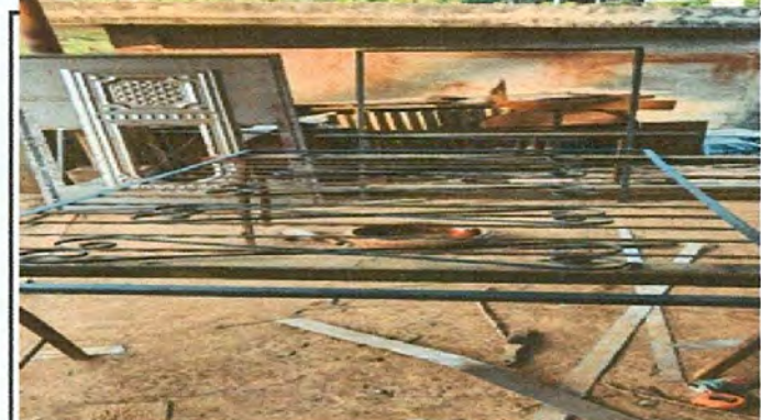
Foto 4: Trabajando los balcones
