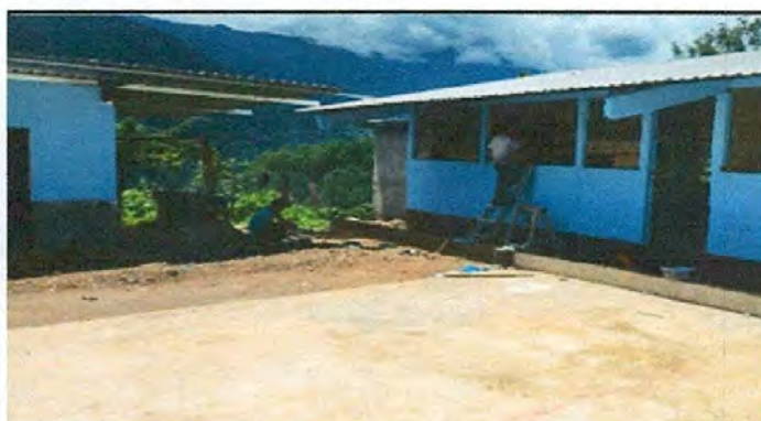
Foto 3: Trabajando en la sustitución de vidrios
