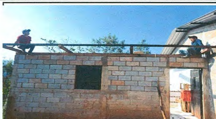
Foto 2: Quitando el techo y la madera para sustituirla por lámina nueva y soporte de metal.
