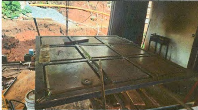
Foto1: Avance en el trabajo del portón
