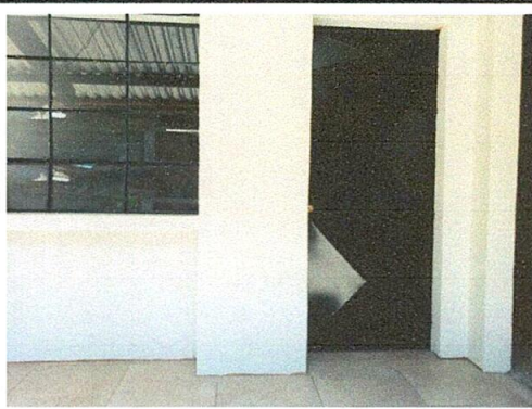
Foto 2: puerta de metal. Mantenimiento a estructura (lijado, cambio de tubo, cepillado, sugeciones y aplicación de pintura)
