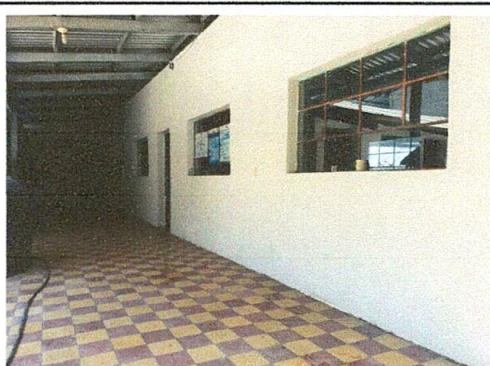
Foto 4: Reparación de repello y cernido de parades. Matenimiento de paredes en aulas.
