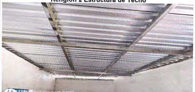
Foto 6: En proceso la colocación de las vigas y reglas de metal
