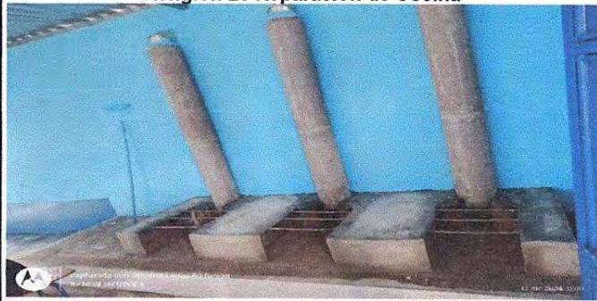
Foto 2: los fogones completados al 100%
