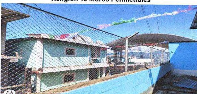
Foto 18: se finalizó el muro con la colocación de la malla
