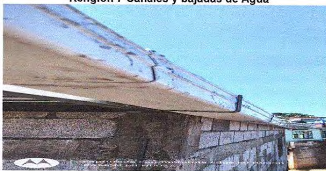
Foto 14: De esta forma quedaron instaladas los canales
