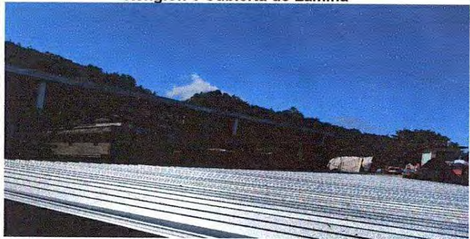
Foto 3: Cubierta de lámina completada al 100%
