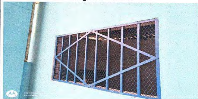
Foto 9: así quedó instalada la venta frontal de la cocina
