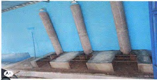
Foto 1: Así quedaron los fogones de la cocina
