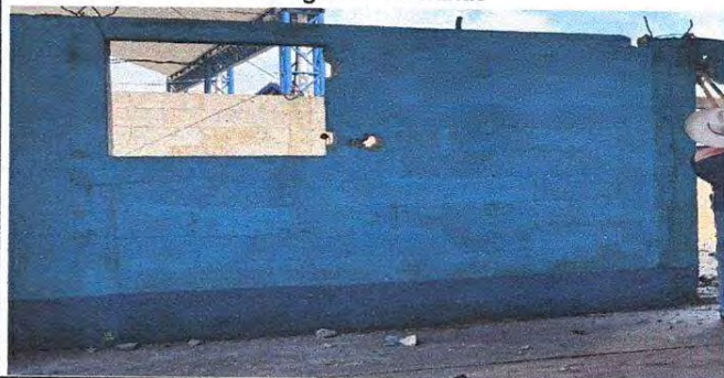
Foto 9: se inicia con la ampliación de la ventana frontal
