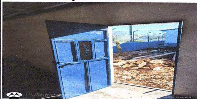
Foto 7: Se mejoraron las condiciones de las puertas
