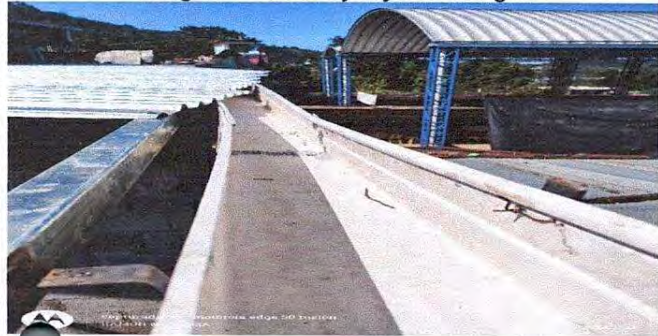
Foto 13: se puede apreciar el avance del cambio de canales
