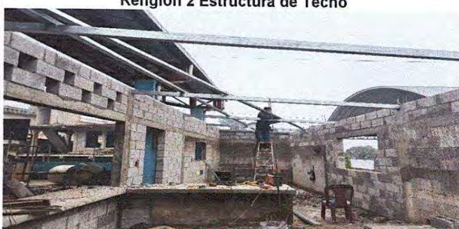
Foto 6: En proceso la colocación de las vigas y reglas de metal
