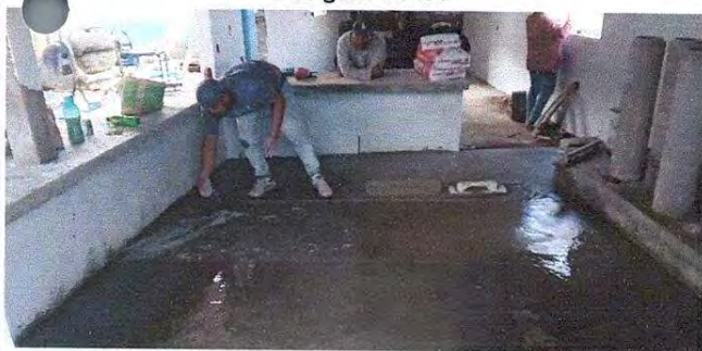
Foto 11: Se inicia el trabajo en el piso
