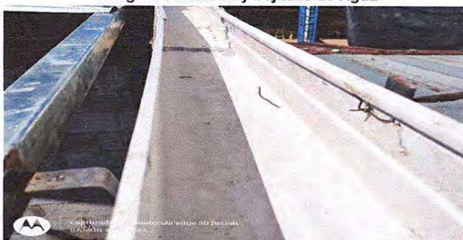
Foto 14: a punto de finalizar el cambio de canales y bajadas de agua
