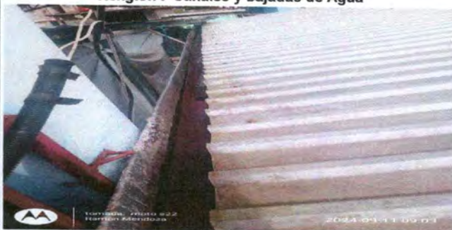
Foto 14: Estado fisico del canal de agua pluvial de metal
