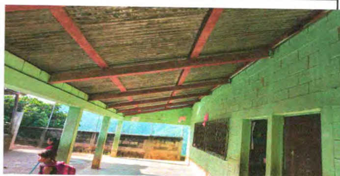
Foto 2: estructura del centro educativo parte de fuera
