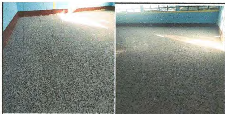
Foto 3: Otras aulas con el piso sustituido
