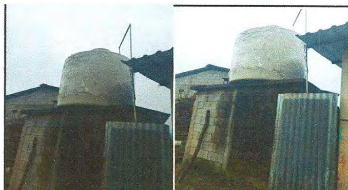
Foto 4: Se evidencia la instalación finalizada del tinaco
