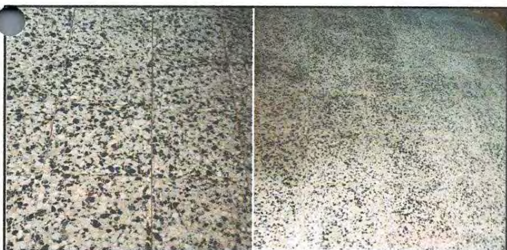
Foto 5: Evidencia de piso nuevo
