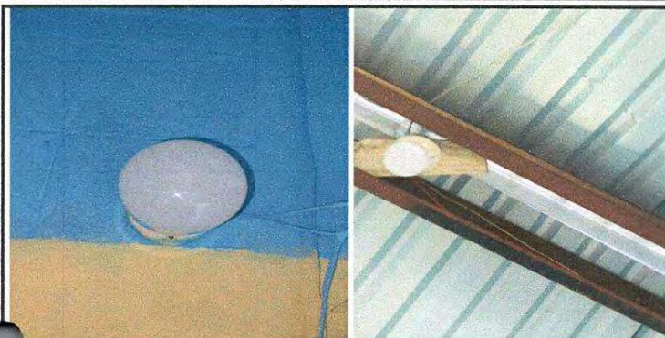
Foto 1: Se evidencia el cambio de lámparas led
