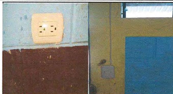
Foto 2: Se evidencia la sustitución de interruptores y de tomacorrientes
