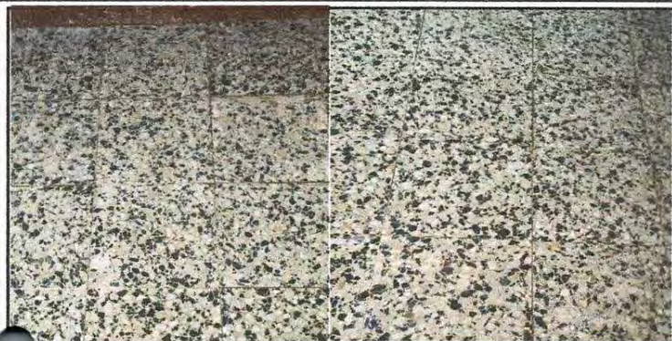
Foto 1: Evidencia de la sustitución de piso
