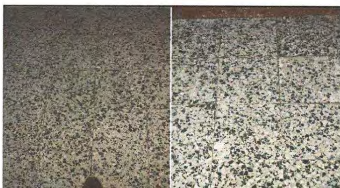
Foto 4: Otras aulas con el piso nuevo
