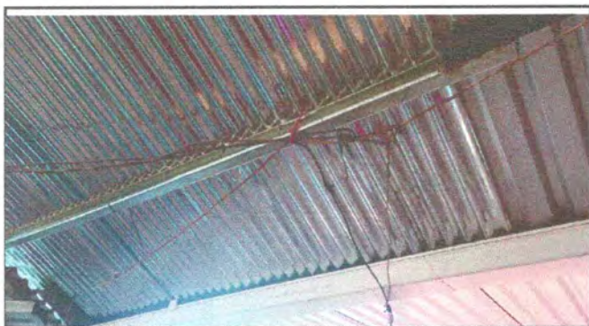
FOTO 9. REPARACION DE SISTEMA ELECTRICO
