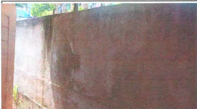
FOTO 7. SUSTITUCION DE PINTURA
