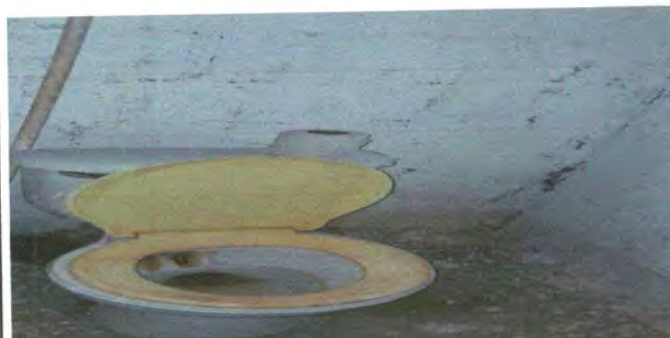
FOTO 5. REPARACION DE BAÑOS
