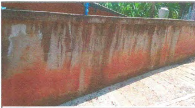
FOTO 10. SUSTITUCION DE PINTURA EN MURO
