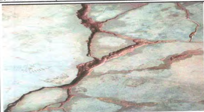
FOTO 1. SUSTITUCION DE TORTA DE CEMENTO POR PISO GRANITO
