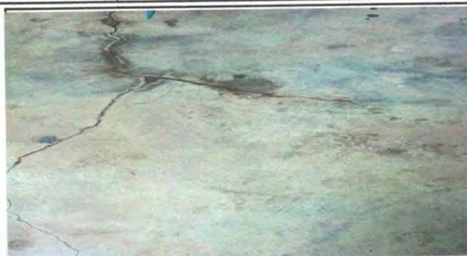
FOTO 2. SUSTITUCION DE TORTA DE CEMENTO POR PISO GRANITO
