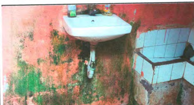
FOTO 3. REARACION DE BAÑOS
