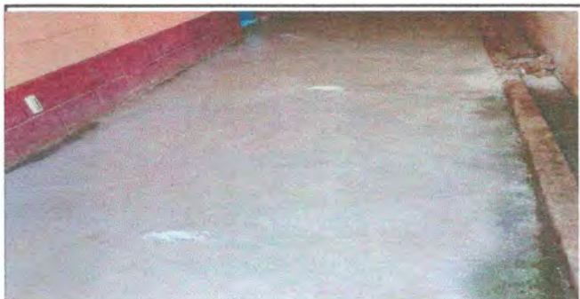
FOTO 12: SUSTITUCION DE PISO
