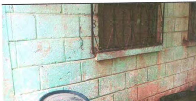
FOTO 6. SUSTITUCION DE PINTURA
