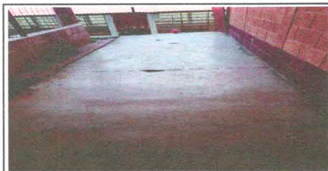
FOTO 11; SUSTITUCION DE PISO
