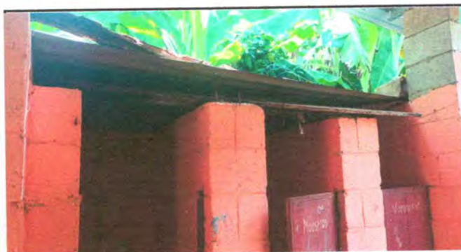
FOTO 4. REPARACION DE BAÑOS
