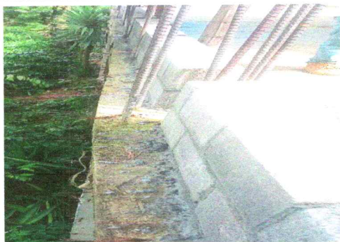
Foto 3. Reparación de muro perimetral de block.
