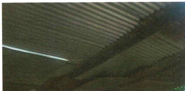
Foto 6. Sustitución de soporte de madera por soporte de metal.
