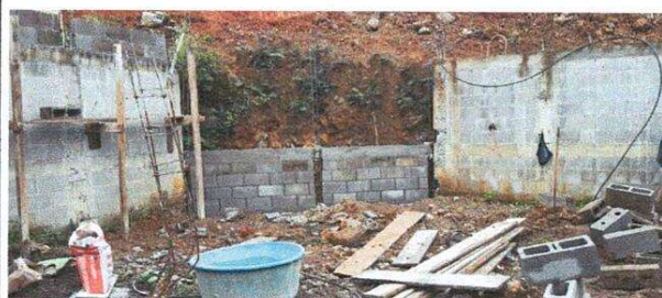
Foto 12: Muro en construcción
