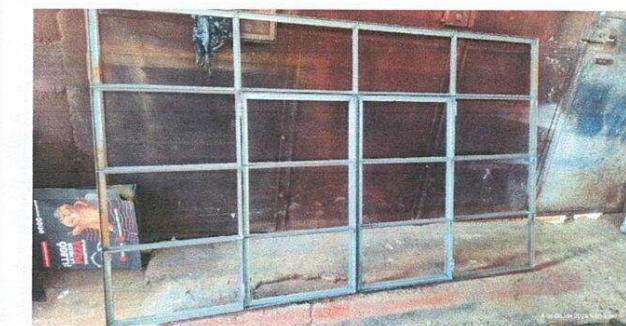
Foto 9: Estructura de metal de ventanas en fabricación
