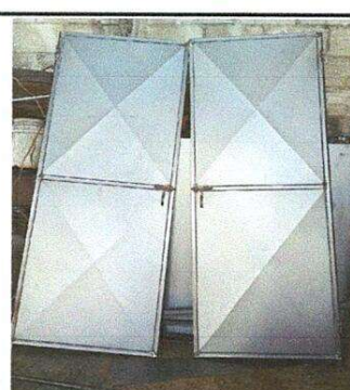
Foto 6: puertas de los sanitarios en fabricación
