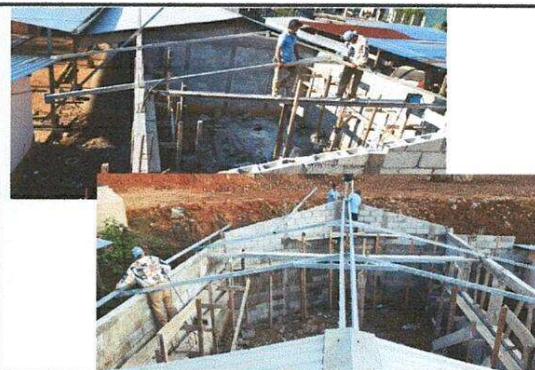
Foto 4: Colocando costaneras
