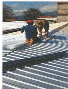
Foto 2: Capotes en colocación
