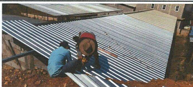
Foto 3: Colocando sujetadores
