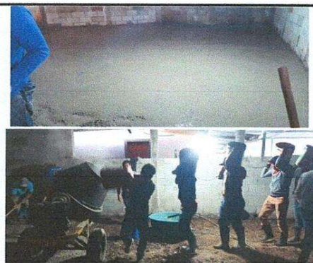
Foto 10: Fundición de piso
