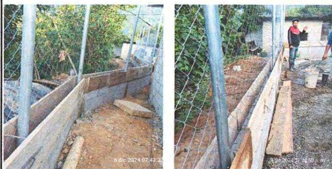
Foto1: Reparación de muro perimetral de block, tubo hg, malla galvanizada, soleras intermedias y columnas.
