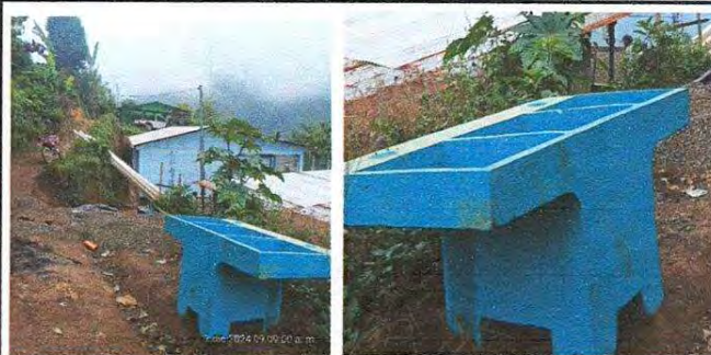
Foto 4: Sustitución de pila de concreto.
