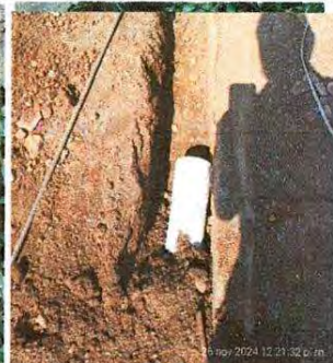
Foto 8: Sustitución de tubería pvc en línea principal de agua fluviales.
