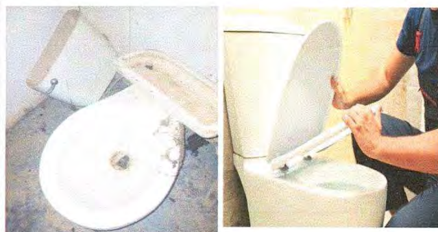
Foto 2: Sustitución de accesorios en taza de baño.
