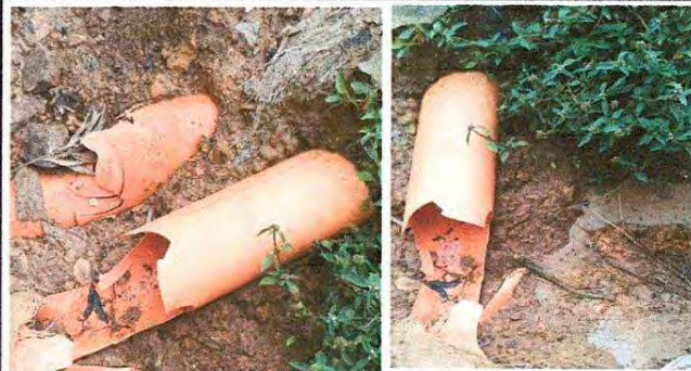
Foto 8: Sustitución de tubería pvc en línea principal de agua fluviales.
