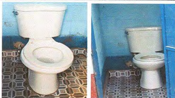
Foto 3: Sustitución de inodoro en baño
