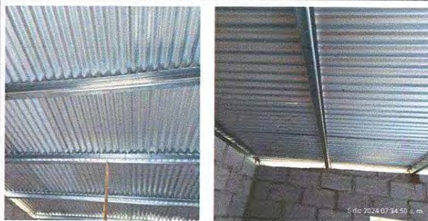
Foto 6: Sustitución de estructura de metal de techo.
