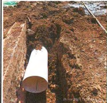
Foto 8: Sustitución de tubería pvc en línea principal de agua fluviales.
