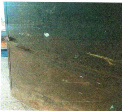
Foto 3: Sustitución de puerta
