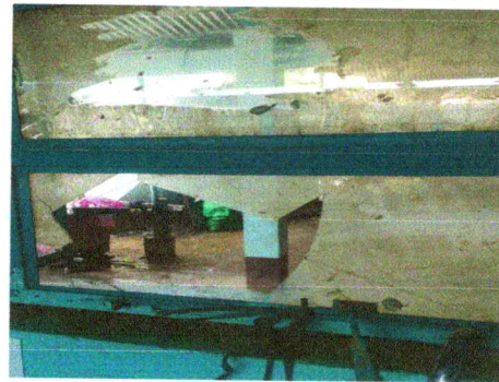
Foto 4: Sustitución de vidrios.
