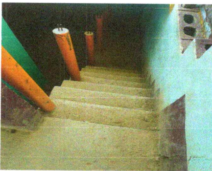
Foto 5: Mantenimiento de baranda.
