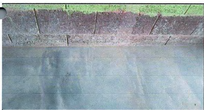
Foto 5: reparación de piso de torta de concreto
