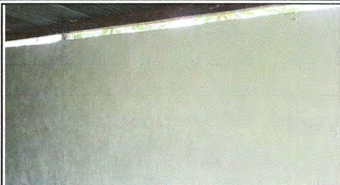
Foto 2: repello en muro
