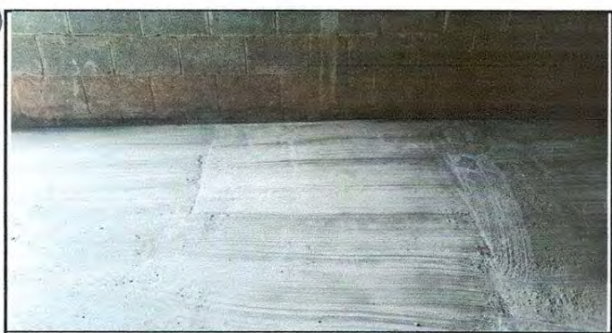
Foto 5: reparación de planchas de concreto de patio
