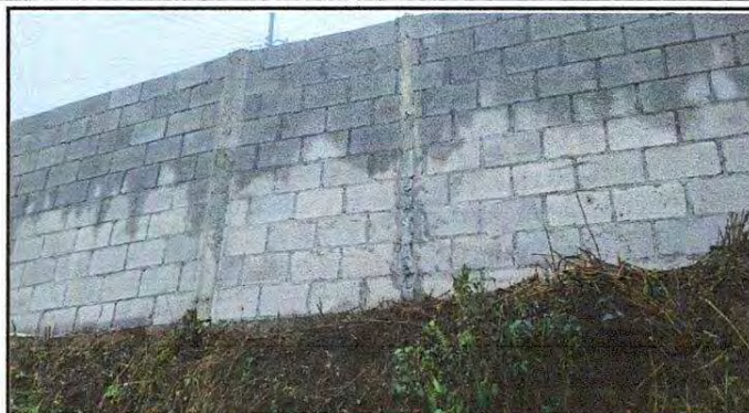
Foto 2: reparación de muro perimetral de block
