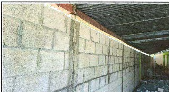
Foto 3: reparación de muro perimetral de block
