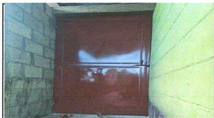
Foto 3: sustitución de puerta
