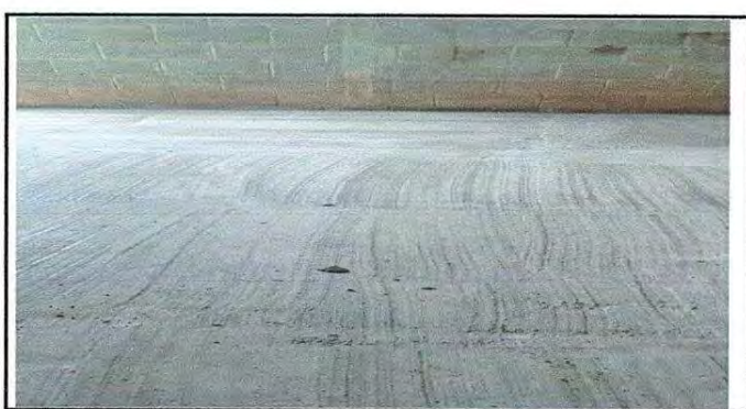
Foto 6: reparación de planchas de concreto de patio
