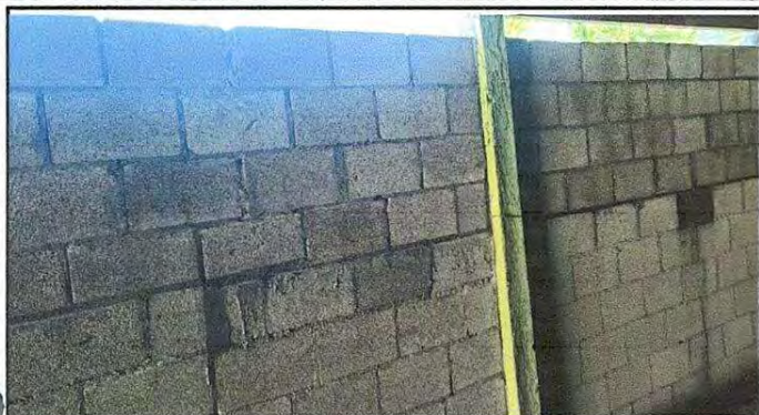
Foto 1: reparación de muro perimetral de block
