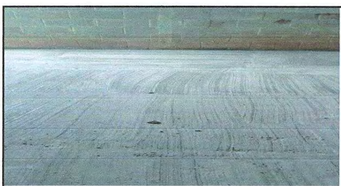
Foto 6: reparación de piso de torta de concreto
