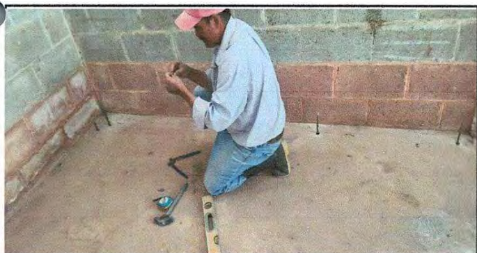
Foto 5: reparación de piso de torta de concreto
