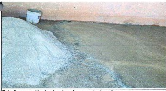
Foto 5: reparación de planchas de concreto de patio
