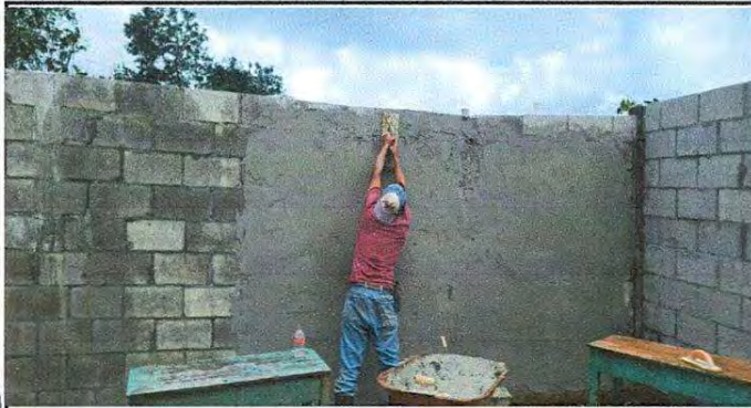
Foto1: repello en muro
