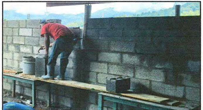
Foto 2: reparación de muro perimetral de block
