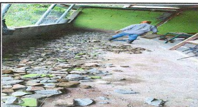
Foto 6: reparación de piso de torta de concreto
