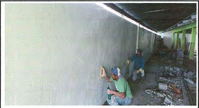
Foto 2: repello en muro
