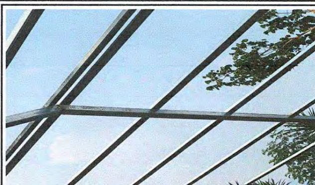
Foto 2: sustitución de lámina por lámina troquelada aluzinc calibre 26
