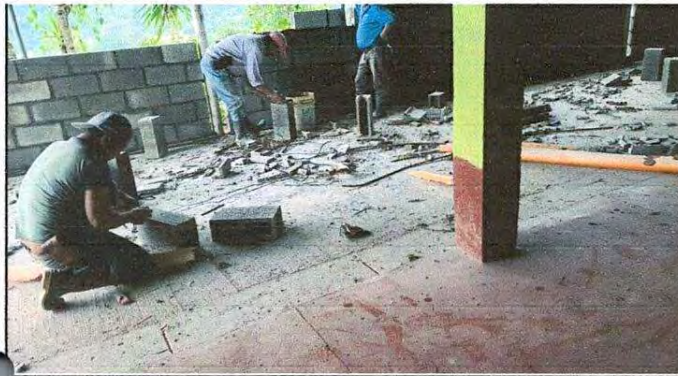
Foto1: reparación de muro perimetral de block
