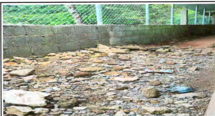
Foto 9: reparación de muro perimetral de block
