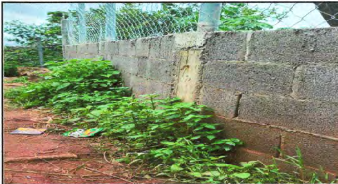
Foto 8: reparación de muro perimetral de block
