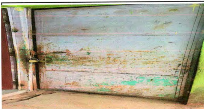
Foto 3: sustitución de puerta
