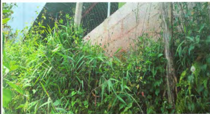
Foto 7: reparación de muro perimetral de block
