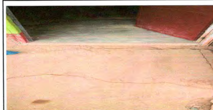
Foto 6: reparación de piso de torta de concreto
