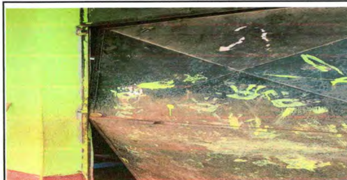
Foto 4: sustitución de puerta
