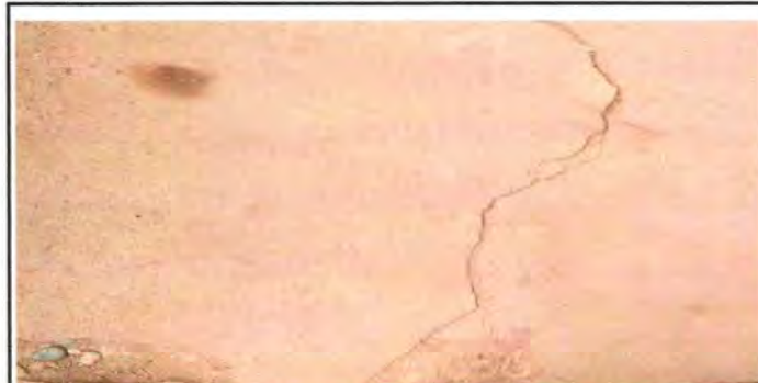
Foto 12: reparación de piso de torta de concreto
