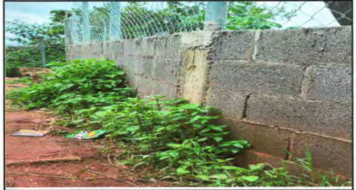
Foto 14: repello en muro
