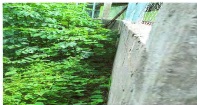
Foto 10: reparación de muro perimetral de block
