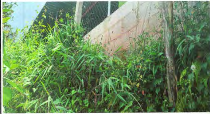
Foto 13: repello en muro
