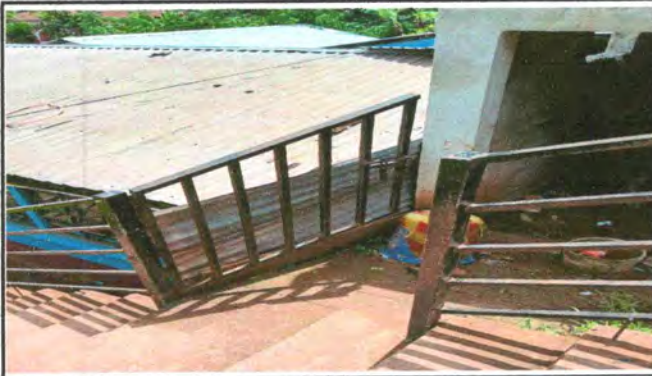
Foto 7 MANTENIMIENTO A BARANDAS
