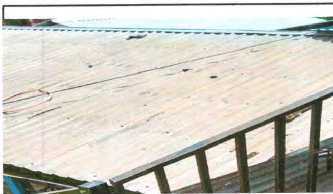
Foto 11 ESTRUCTURA DE TECHO
