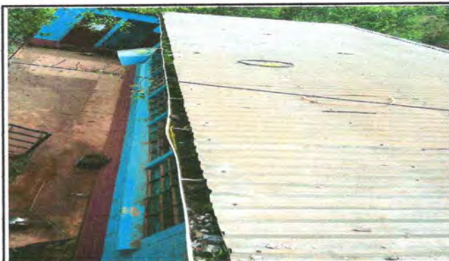
Foto 9 BCANALES DE BAJADA DE AGUA PLUVIAL
