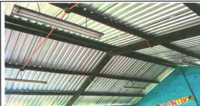
Foto 6: REPARACION DEL SISTEMA ELECTRICO
