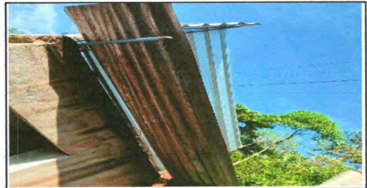
Foto 10 CUBIERTA DE LAMINA
