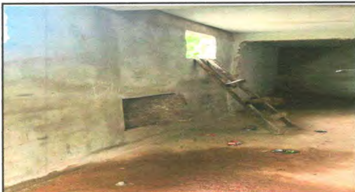
Foto 3: PINTURA EN MUROS EXTERIORES E INTERIORES
