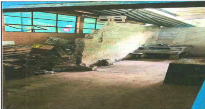
SUSTITUCION DE PISO CERAMICO
