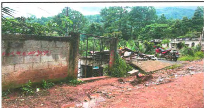
Foto 5: MANTENIMIENTO A PORTONES
