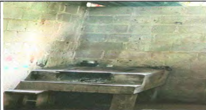
Foto 2 REPARACION DE COCINA
