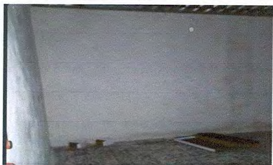
Foto 5: Repello y cernido de paredes
