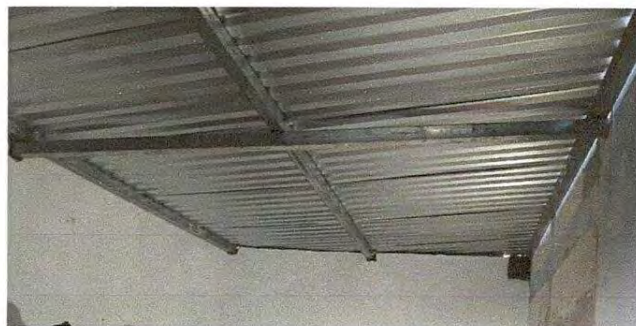
Foto 2: Estructura de techo de metal
