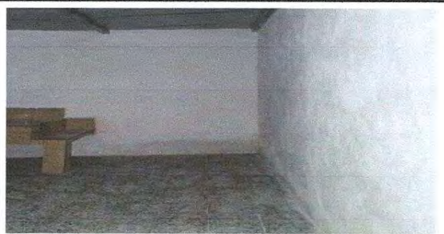
Foto 6: Muro perimetral de block
