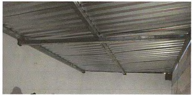
Foto 4: Techo de lamina troquelada
