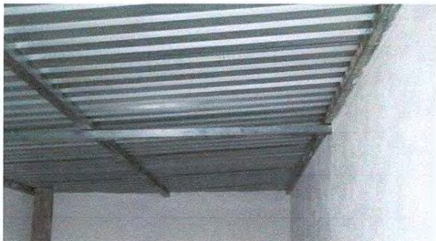
Foto1: Estructura de techo de metal
