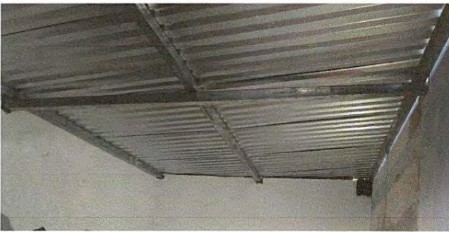
Foto 3: Techo de lamina troquelada
