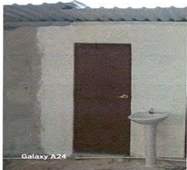
Foto13: Puerta de servicio sanitario
