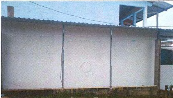
Foto 5: Muro perimetral de block
