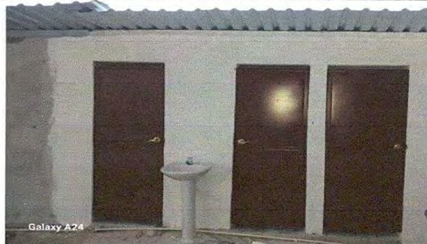
Foto 14: Puerta de servicio sanitario
