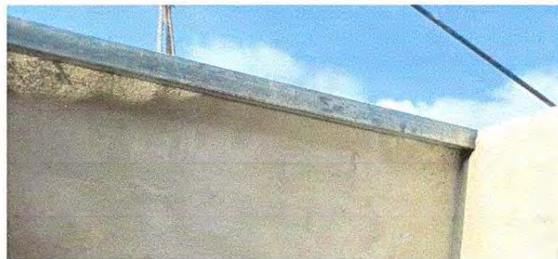
Foto 8: Sustrucción de estructura
