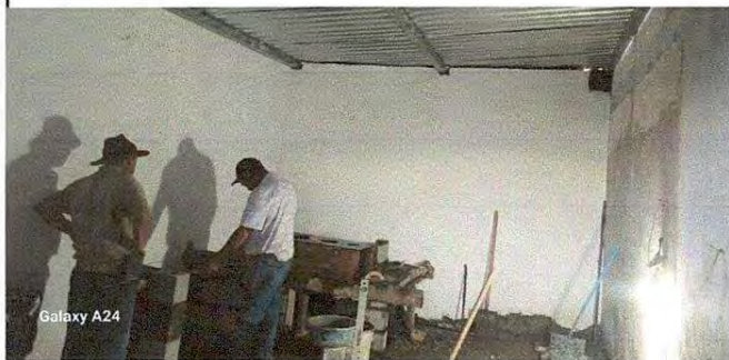
Foto1: Reparación de cocina
