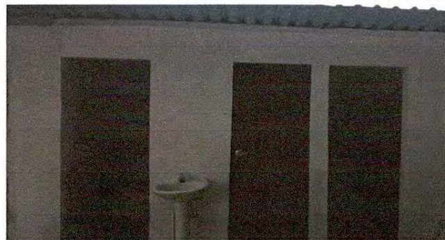
Foto 14: Sustrucción de purta de metal en servicio sanitario
