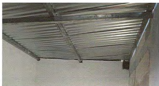
Foto 4: Cubierta de lámina
