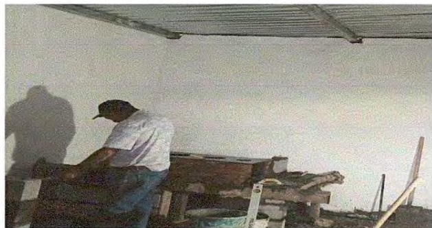
Foto 2: Reparación de cocina
