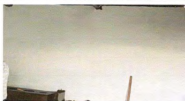
Foto 12: Reparación de repello y cernido de paredes
