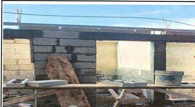
Foto 22 : Sustrucción de lavamanos
