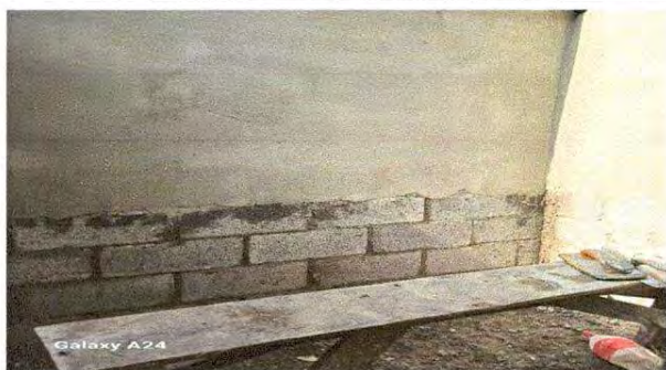
Foto 11: Reparación de repello y cernido de paredes
