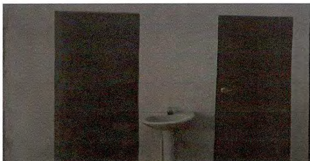
Foto 13: Sustrucción de purta de metal en servicio sanitario
