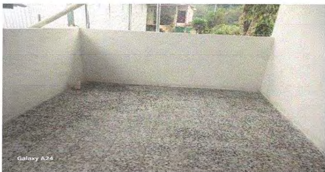
Foto 19 : Sustrucción de pila de cemento
