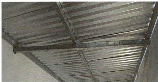
Foto 7: Sustrucción de estructura
