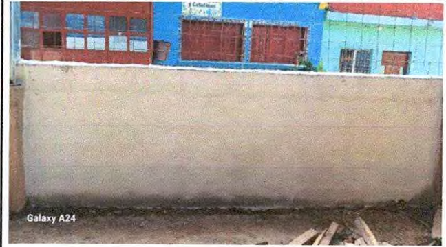
Foto 26: Reparacion de muro perimetral.
