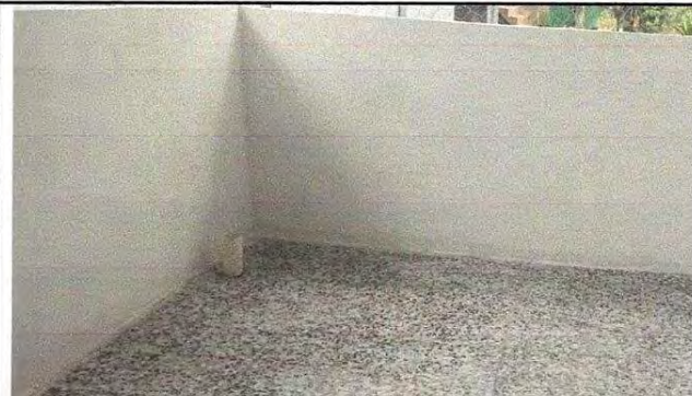
Foto 20 : Sustrucción de pila de cemento
