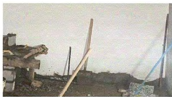
Foto 10: Sustrucción de piso
