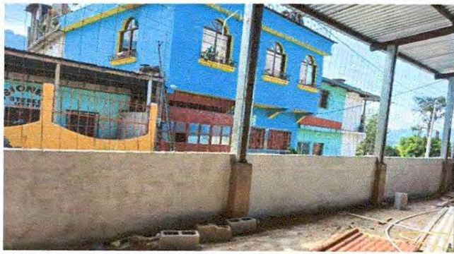
Foto 25: Reparacion de muro perimetral.
