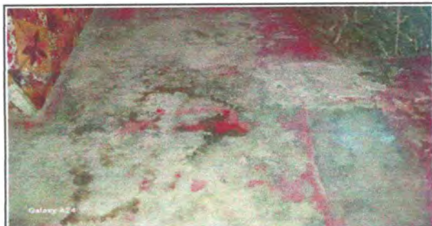
Foto 9: Reparación de piso
