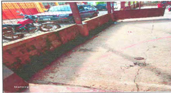
Foto 26 : Sustrucción de muro perimetral
