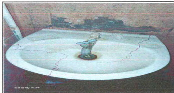
Foto 21: Sustrucción de lavamanos
