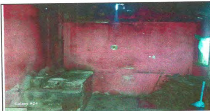
Foto 5: Reparación de muro perimetral de block
