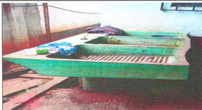
Foto 19 : Sustrucción de pila de cemento de dos lavaderos
