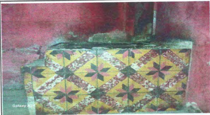
Foto1: Reparación de cocina
