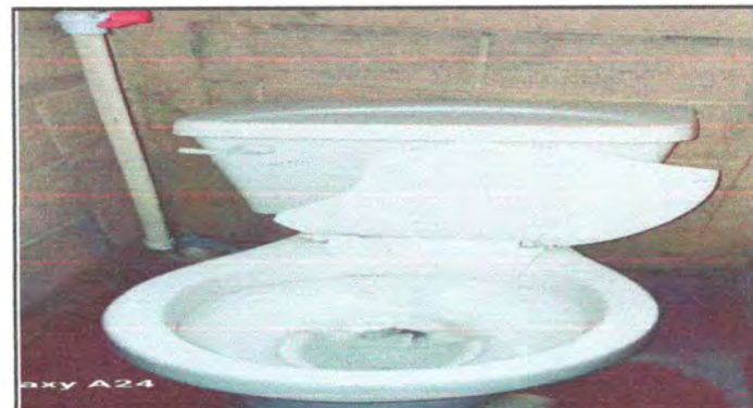
Foto 16 : Sustitución de Inodoro
