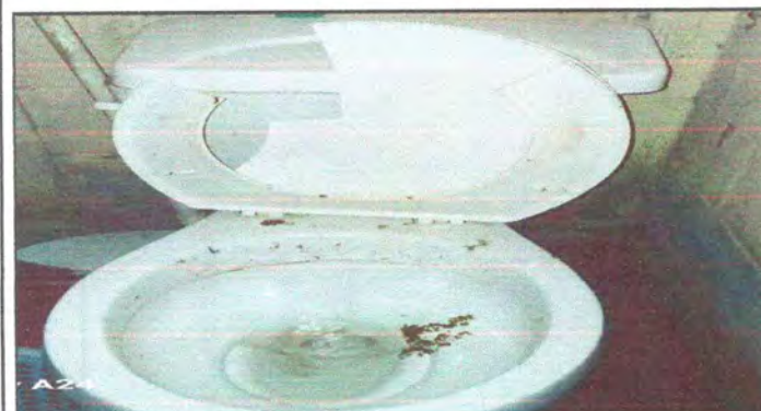
Foto 15 : Sustitución de Inodoro
