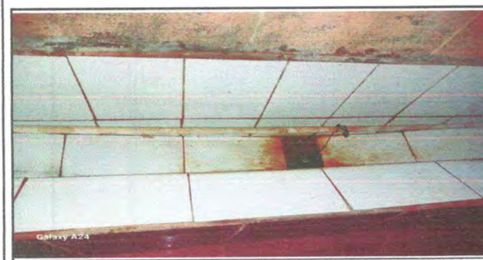
Foto 17: Sustitución de mingitorio
