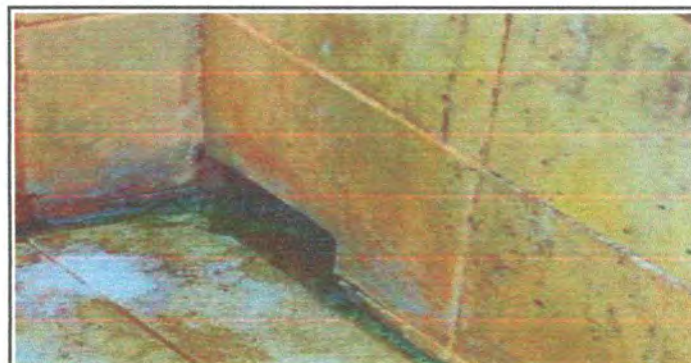
Foto 24: Sustrucción de azulejo en baño
