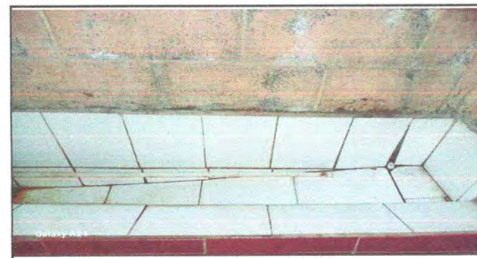
Foto 18: Sustitución de mingitorio
