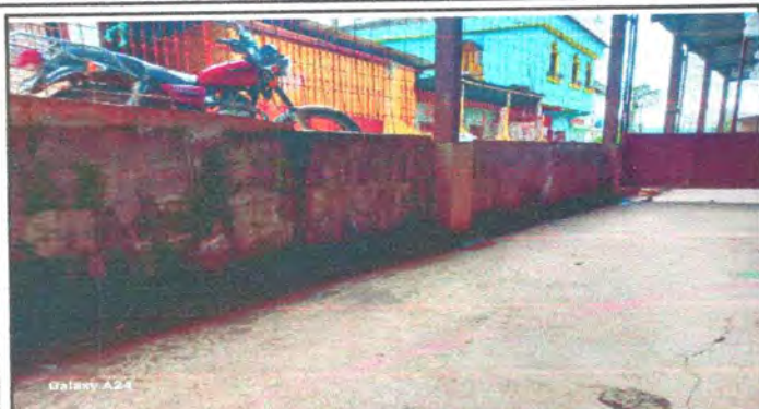
Foto 25 : Sustrucción de muro perimetral
