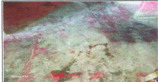
Foto 10: Reparación de piso de cemento
