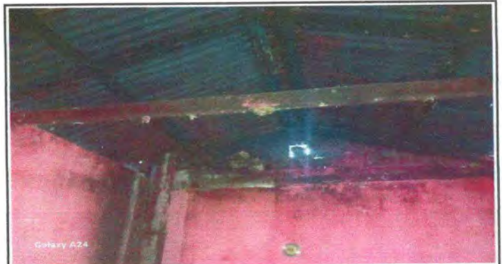
Foto 4: Cubierta de lámina
