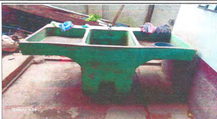
Foto 20 : Sustrucción de pila de cemento de dos lavaderos
