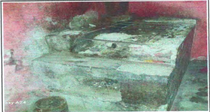
Foto 2: Reparación de cocina
