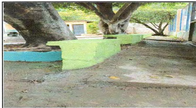
Foto 10: Reparación de banquetas de concreto
