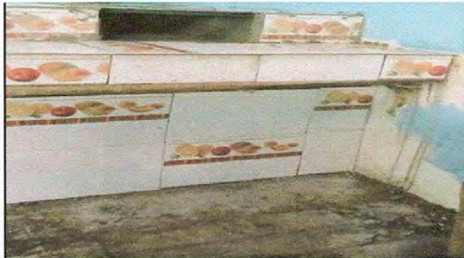
Foto 14: Reparación de azulejo en muebles de cocina
