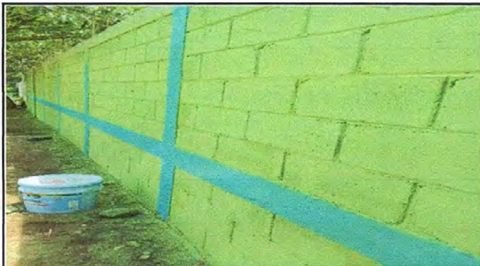
Foto 7: Pintura en muros exteriores e interiores
