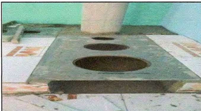
Foto 9: Sustitución de plancha de metal de 3 hornillas
