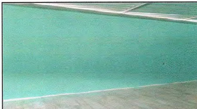
Foto 4: Mejoramiento de paredes
