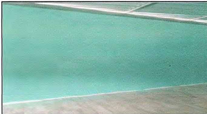
Foto 13: Repello de paredes
