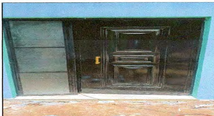
Foto 3: Sustrucción de puerta
