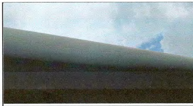
Foto 6: Sustrucción de canal pvc
