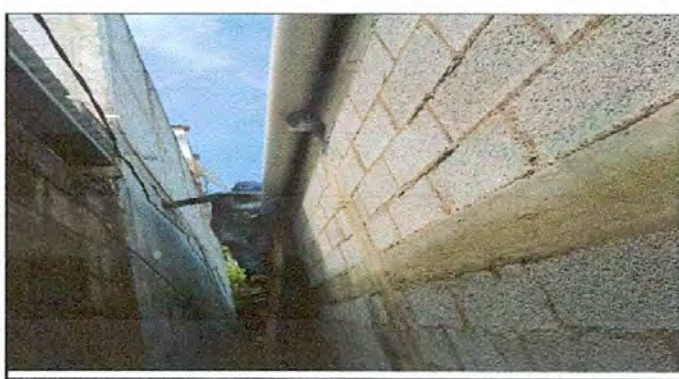
Foto 6: Sustitución de canal pvc
