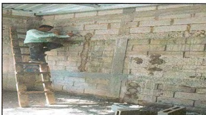
Foto 4: Mejoramiento de paredes
