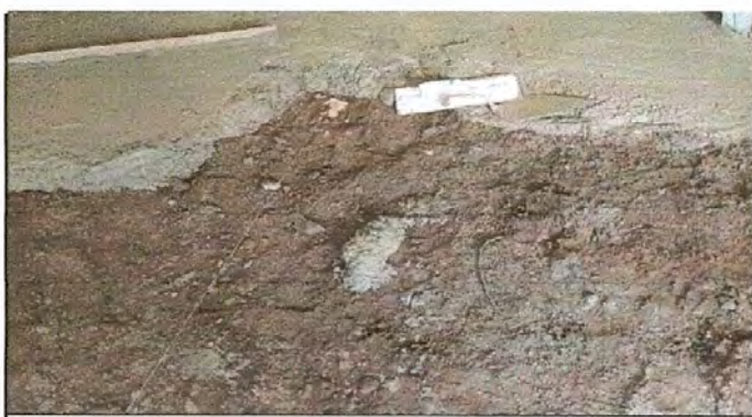
Foto 5: Sustitución de piso de torta de concreto
