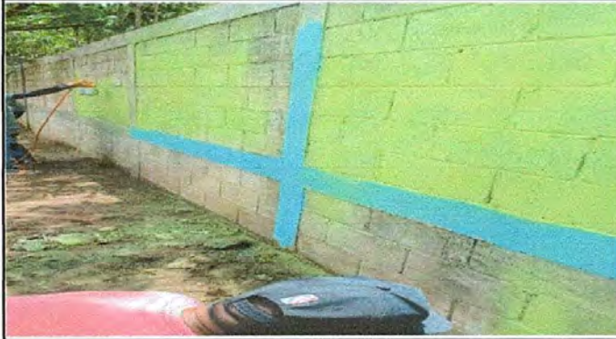
Foto 7: Pintura en muros exteriores e interiores
