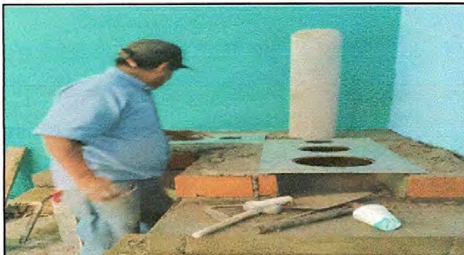
Foto 9: Sustitución de plancha de metal de 3 hornillas
