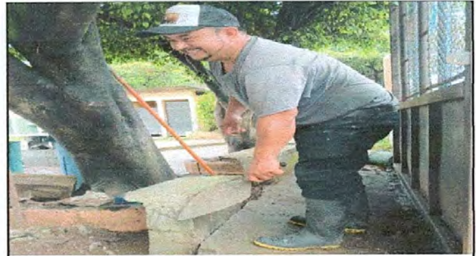
Foto 10: Reparación de banquetas de concreto
