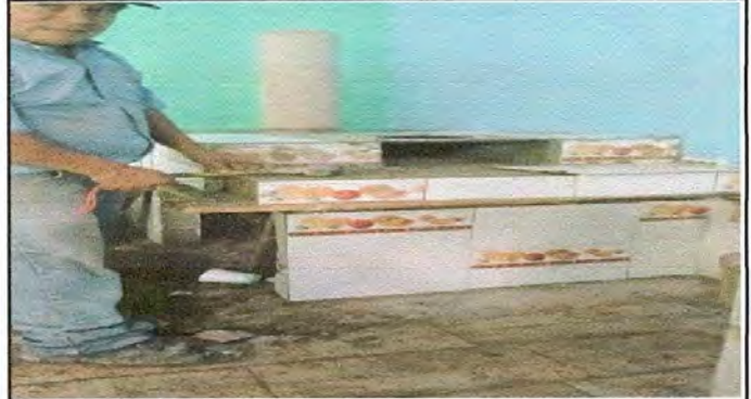
Foto 14: Reparación de azulejo en muebles de cocina
