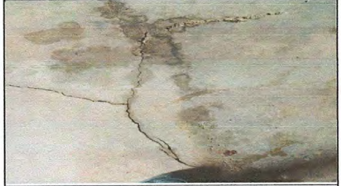
Foto 8: Reparación de piso cerámico
