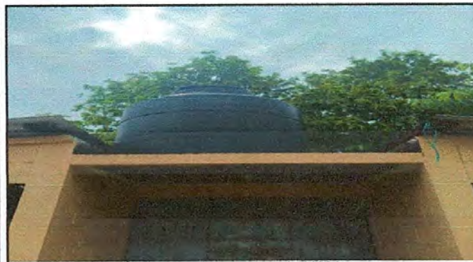
Foto 11: Sustitución de depósitos de agua de 1100 lt
