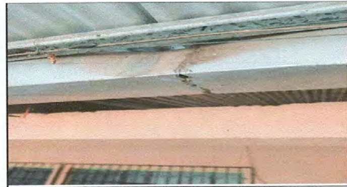
Foto 6: Sustitución de canal pvc
