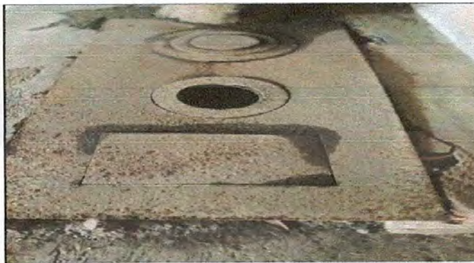
Foto 9: Sustitución de plancha de metal de 3 hornillas
