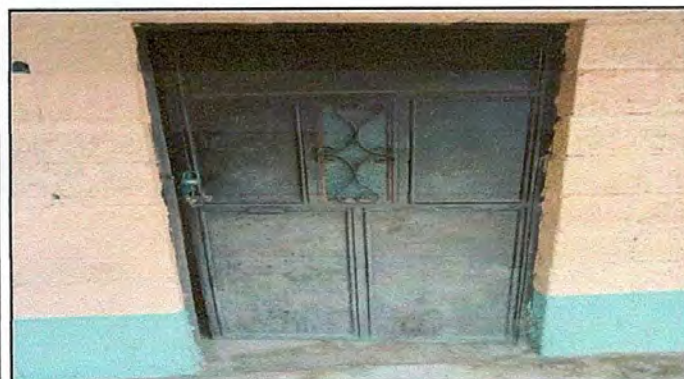
Foto 3: Sustitución de puerta
