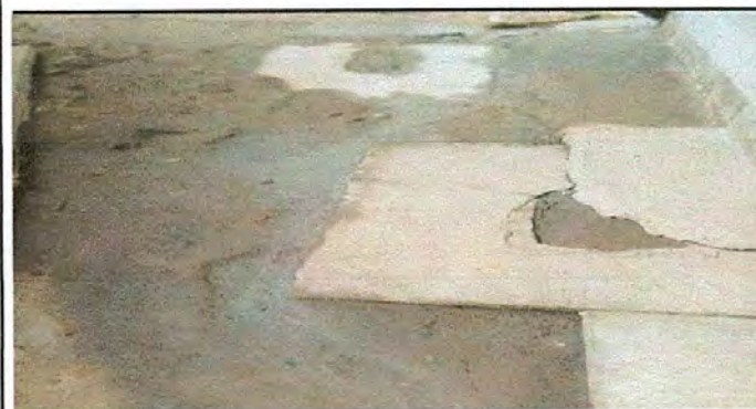
Foto 5: Sustitución de piso de torta de concreto
