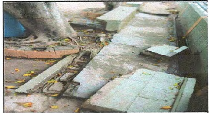
Foto 10: Reparación de banquetas de concreto
