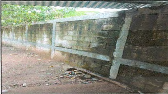
Foto 7: Pintura en muros exteriores e interiores
