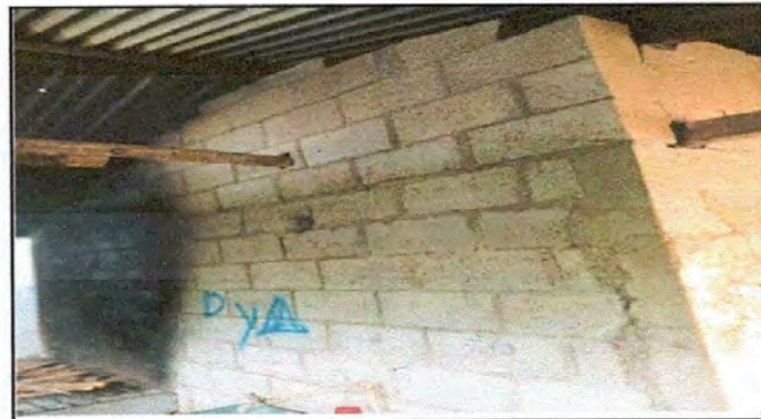
Foto 4: Mejoramiento de paredes
