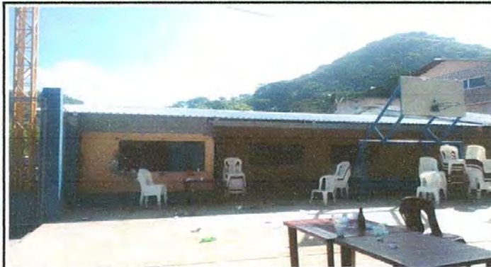
Foto1: Techo de lamina instalado
