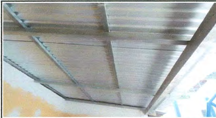
Foto 2: Estructura de mental instalado
