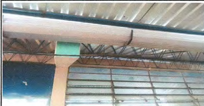
Foto1: Canal de agua instalado
