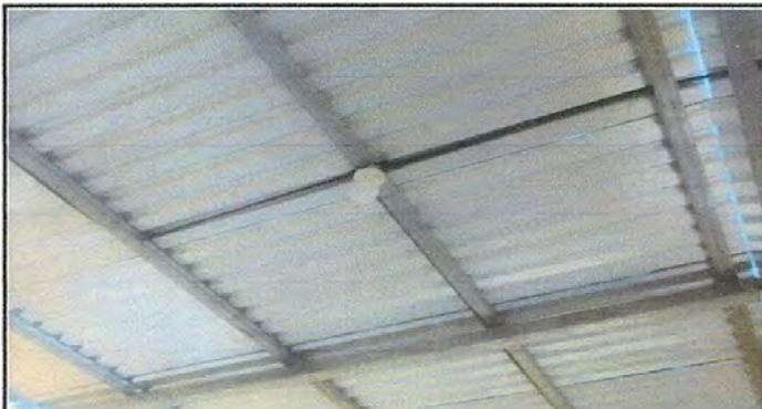
Foto1: Foco ahorrador instalado
