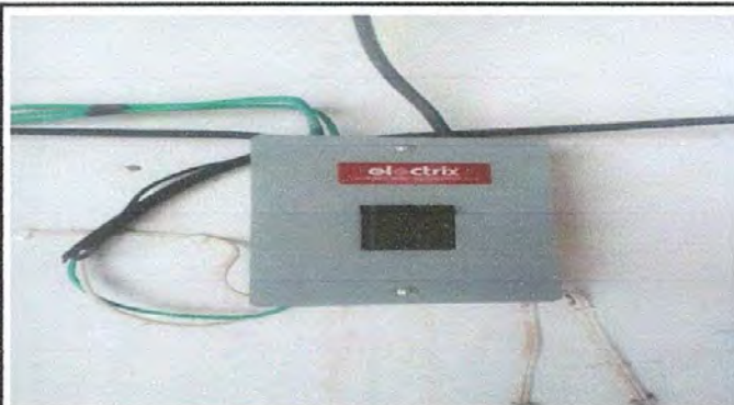
Foto 4: Flipón instalado
