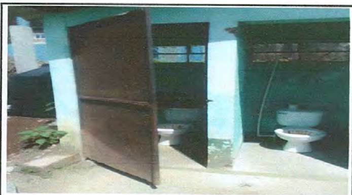
Foto 3: Eliminación de las puertas en mal estado
