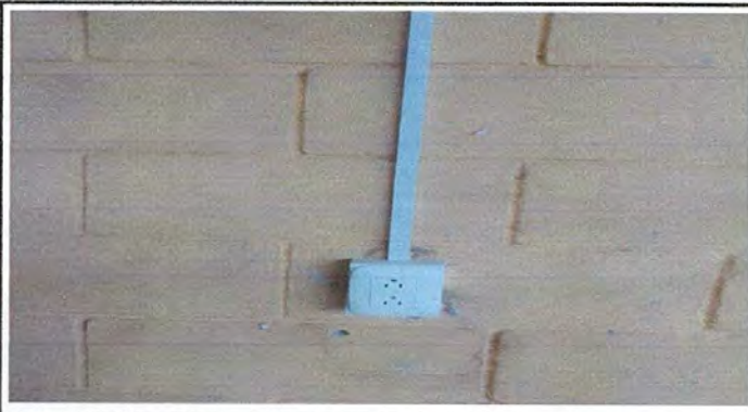
Foto 3: Instalando tomacorrientes
