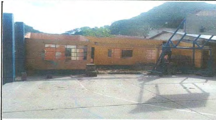
Foto 1: Eliminación de lamina en mal estado
