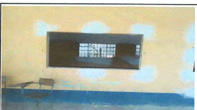
Foto 4: Eliminación del balcon
