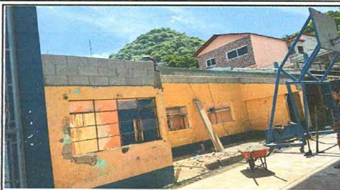
Foto 2: Eliminación de la madera del techo
