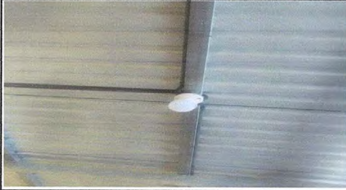
Foto1: Instalando focos ahorradores
