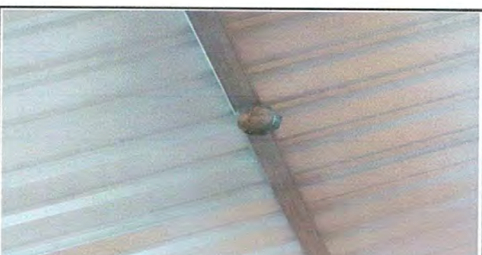
Foto 6: instalación de flaponera
