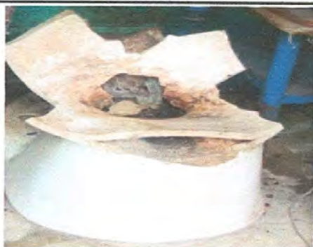
foto 11 SUSTITUCIÓN DE INODOROS
