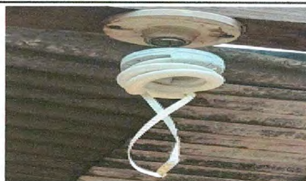
foto 6 SUSTITUCION DE FLAPONERA
