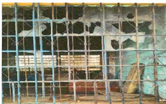
foto 4 SUSTITUCION DE BALCONES
