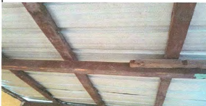
foto 2 SUSTITUCIÓN DE ESTRUCTURA DE SOPORTE
