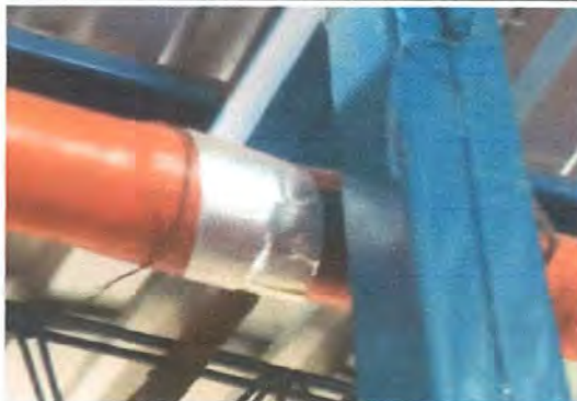
FOTO 13 DE CNAL PVC BAJADA DE AGUA POR GALVANIZADO
