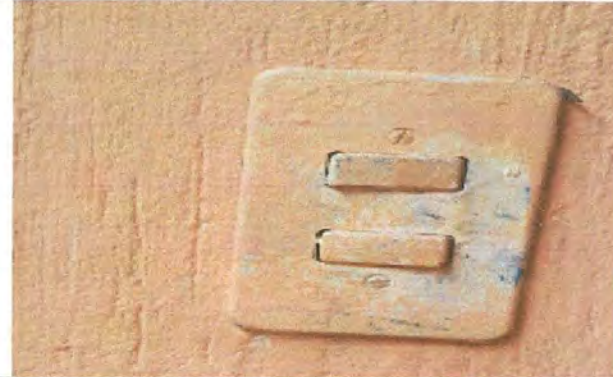
Foto 8 SUSTITUCIÓN DE INTERRUPTORES
