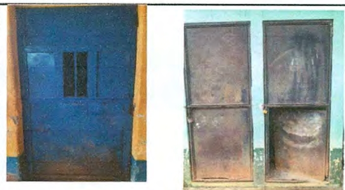
foto 3 SUSTITUCIÓN DE PUERTAS
