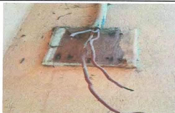
foto 10 SUSTITUCION DE FLIPON
