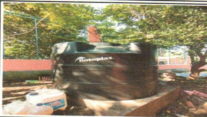
Foto 8: Depósito de agua 1700 lt ya instalado
