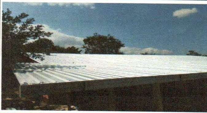
Foto 1: Lámina troquelada aluzinc calibre 26 y Sustitución de elementos de fijación ya instalados
