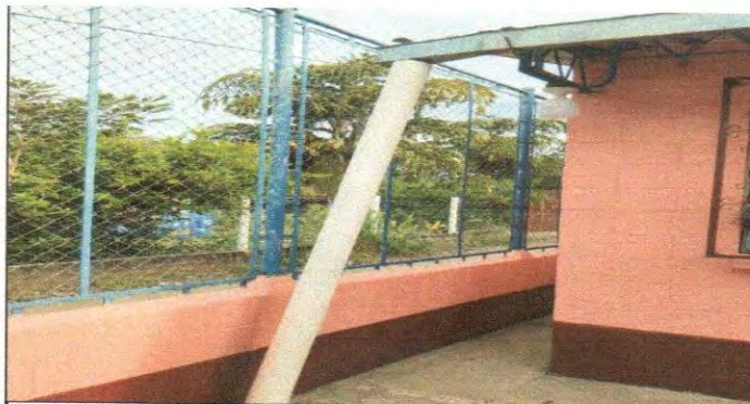
Foto 5. Sustitución de bajada de agua pluvial de tubo Pvc por tubo PVC 4" ya instalados
