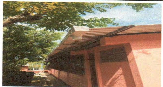
Foto 4: Canal colonial Pvc ya instalado
