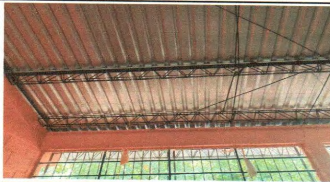
Foto 3: Estructura de soporte de metal ya instalado
