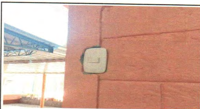
Foto 4: Interruptores simples ya instalados
