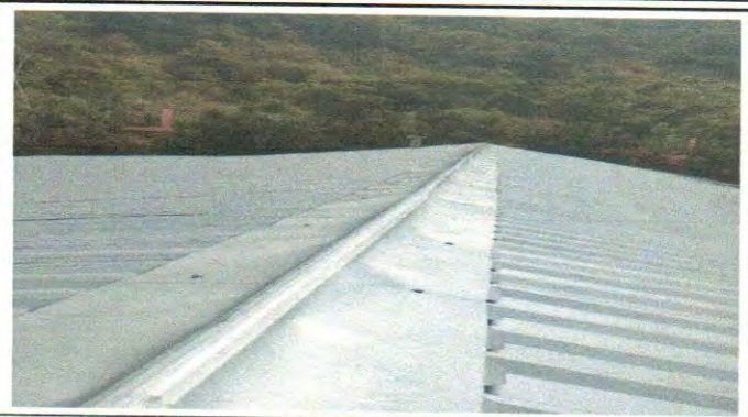
Foto 2: Capote de lámina para lámina troquelada ya instalada
