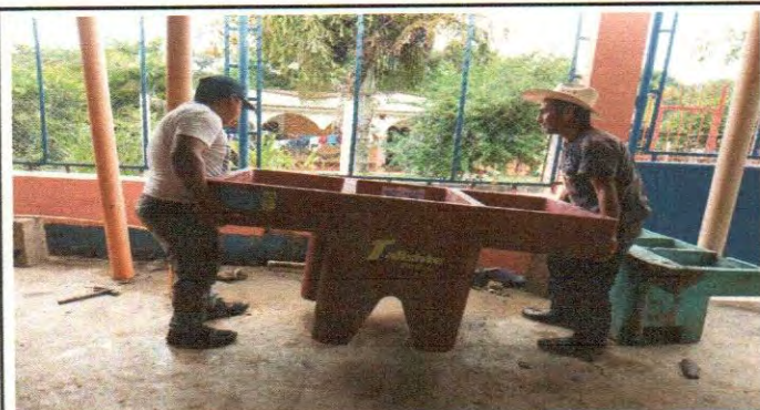
Foto 9: Instalación de pila plastica de dos lavaderos
