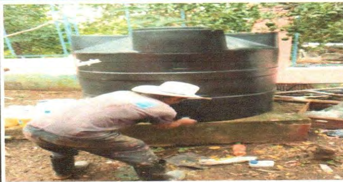
Foto 8: Instalación de depósito de agua 1700 lt
