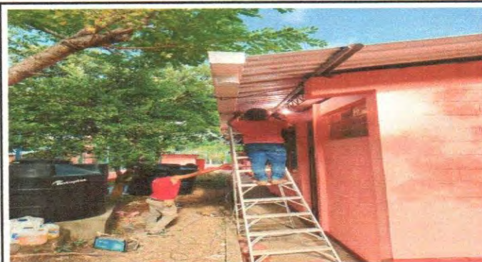
Foto 4: Instalación de canal colonial Pvc
