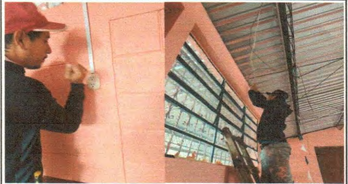
Foto 2: Instalación de tomacorrientes dobles y de cableado Sólido
