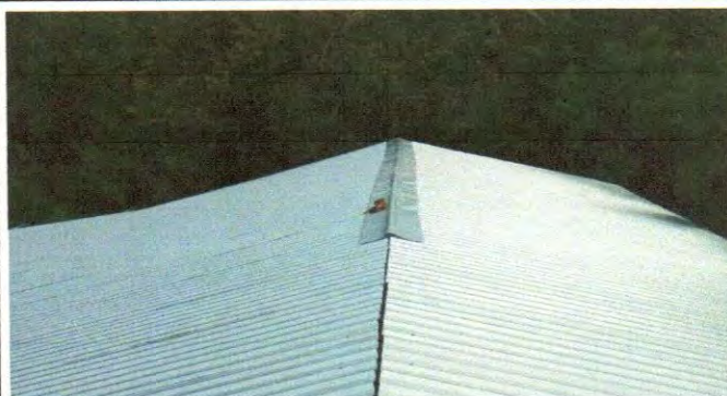
Foto 2: Instalación de capote de lámina para lámina troquelada
