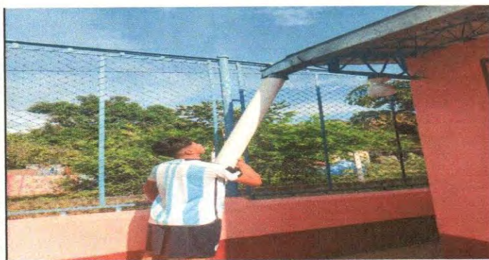
Foto 5: Sustitución de bajada de agua pluvial de tubo Pvc por tubo PVC 4"
