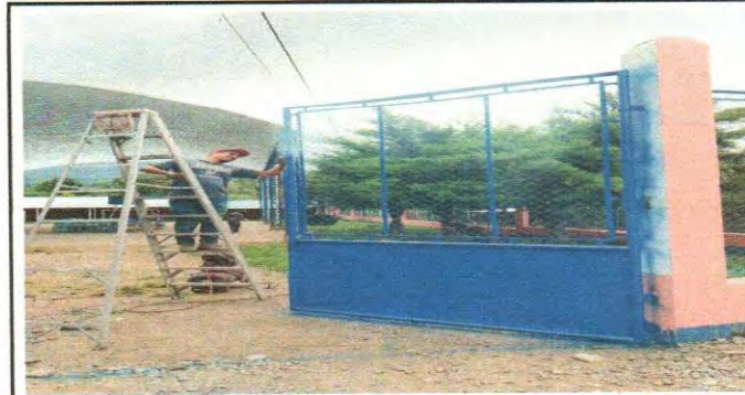
Foto 12: Lijado, cepillado y aplicación de pintura de portón
