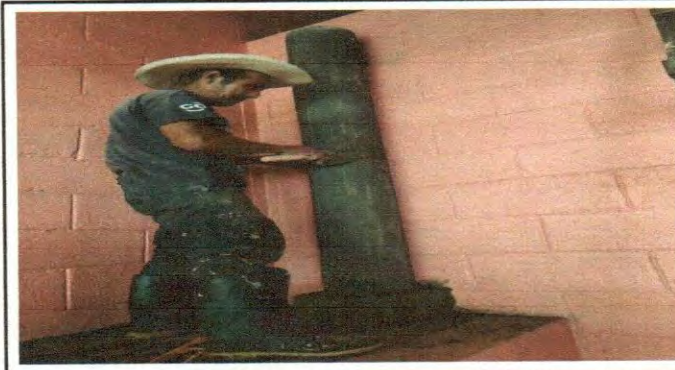
Foto 10: Instalación de chimenea de concreto
