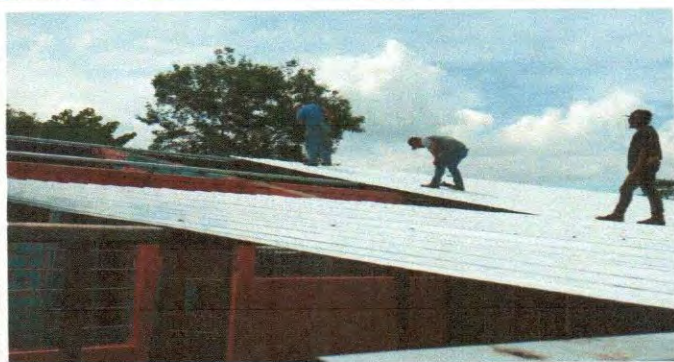
Foto 1: Instalación de lámina troquelada aluzinc calibre 26 y Sustitución de elementos de fijación
