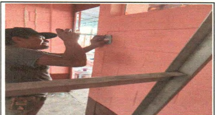
Foto 4: Instalación de interruptores simples
