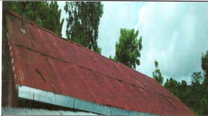
Foto 1: Sustrucción de lámina, por lámina troquelada aluzinc calibre 26 y Sustrucción de elementos de fijacion
