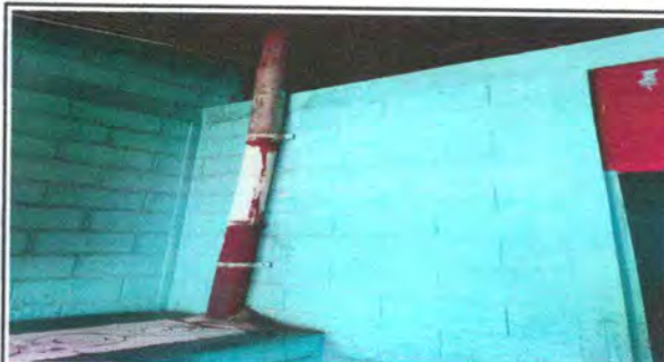
Foto 10: Sustitución de chimenea de metal, por chimenea de concreto
