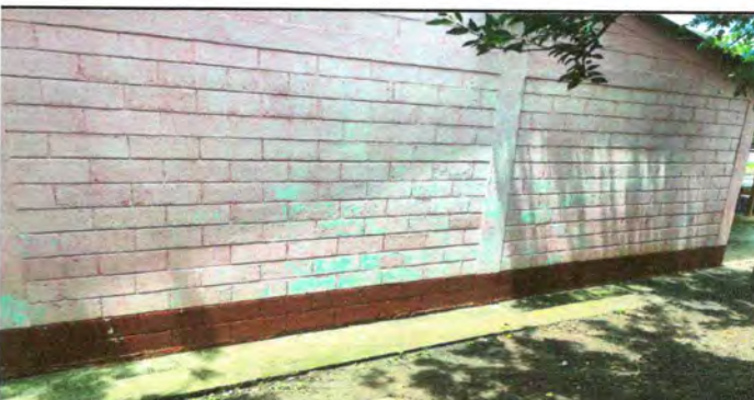
Foto 6: Pintura en muros exteriores e interiores
