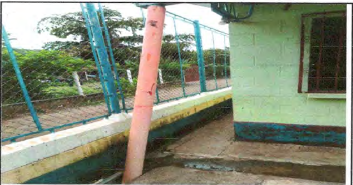
Foto 5: Sustrucción de bajada de agua pluvial de tubo Pvc por tubo PVC 3"
