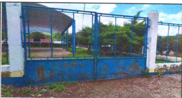
Foto 12: Mantenimiento de portón (lijado, cepillado, aplicación de pintura)
