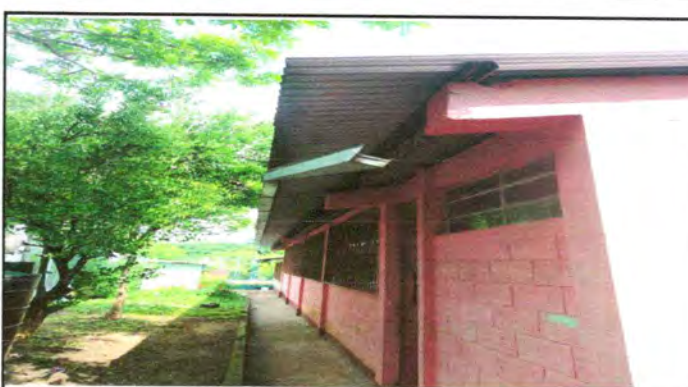
Foto 4: Sustrucción de canal de metal por canal colonial Pvc
