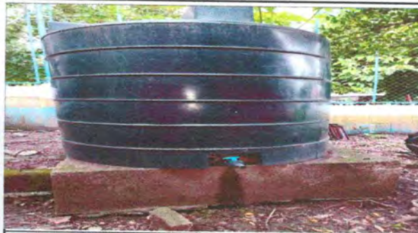
Foto 8: Sustitución de depósito de agua 1700lt
