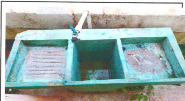
Foto 9: Sustitución de pila de cemento de dos lavaderos, por pila plástica de dos lavaderos
