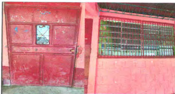
Foto 11: Mantenimiento a estructura de puertas y ventanas (lijado, cepillado, aplicación de pintura)
