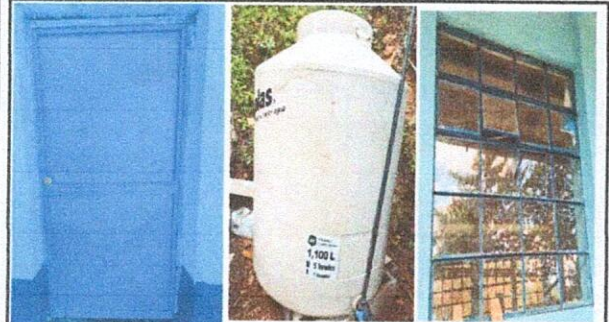
Foto 3: puerta, tinaco y ventana finalizado
