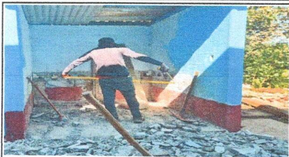
Foto1: trabajando pila de concreto
