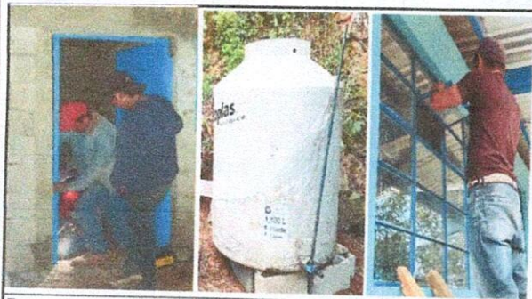
Foto : instalación de puerta, tinaco y ventana
