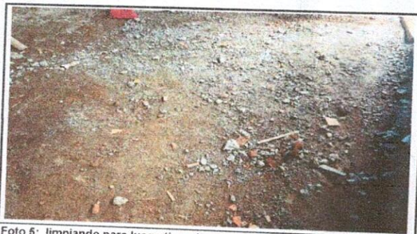
Foto 5: limpiando para luego tirar el cemento.
