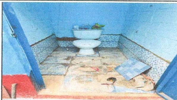
Foto 2: azulejos en inodoros
