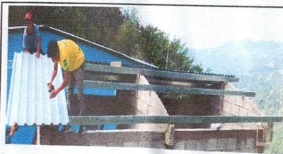
Foto 4: instalación de estructura de techo
